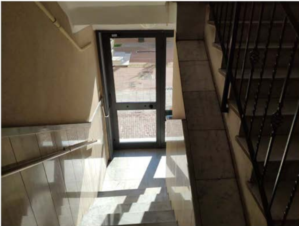
Foto n°4 – Vista interna atrio e accesso scale condominiali
