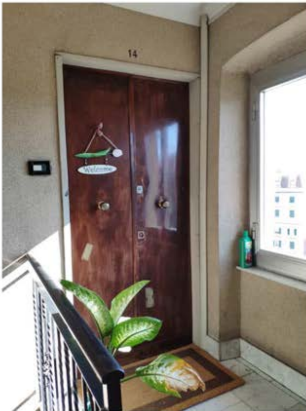
Foto n° 6 – Vista esterna – portoncino ingresso
