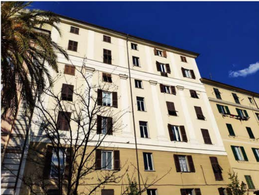
Foto n°2 – Vista esterna accesso immobile Piazza Luigi Settembrini civ. 4
