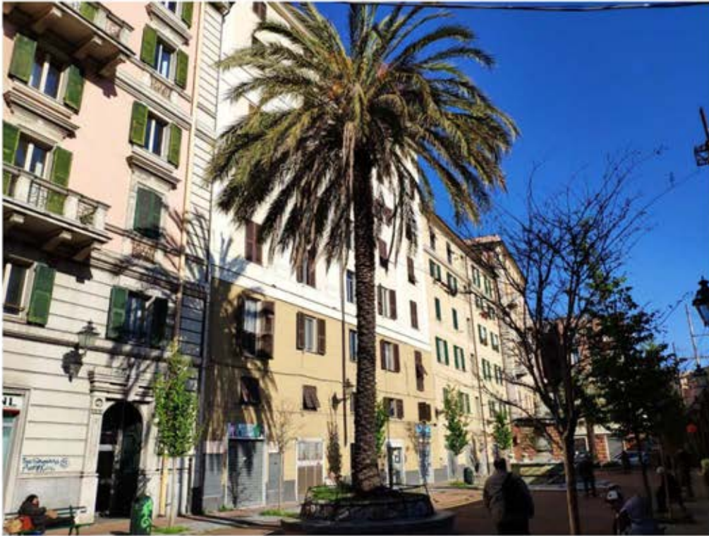
Foto n°1 – Vista esterna immobile Piazza Luigi Settembrini civ. 4
