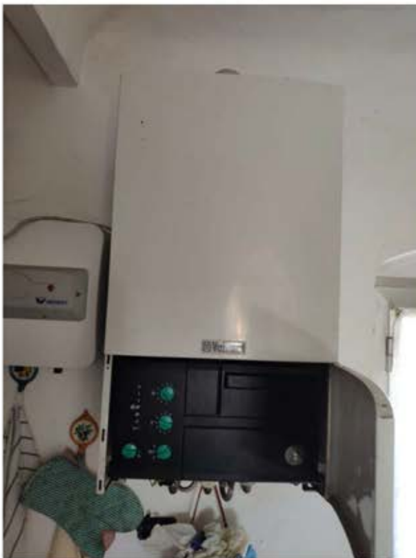
Foto n°20 – Vista interna particolare – calderina
