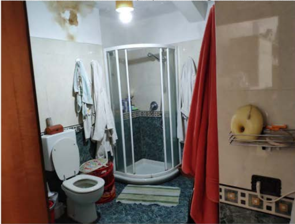
Foto n°15 – Vista interna locali – bagno
