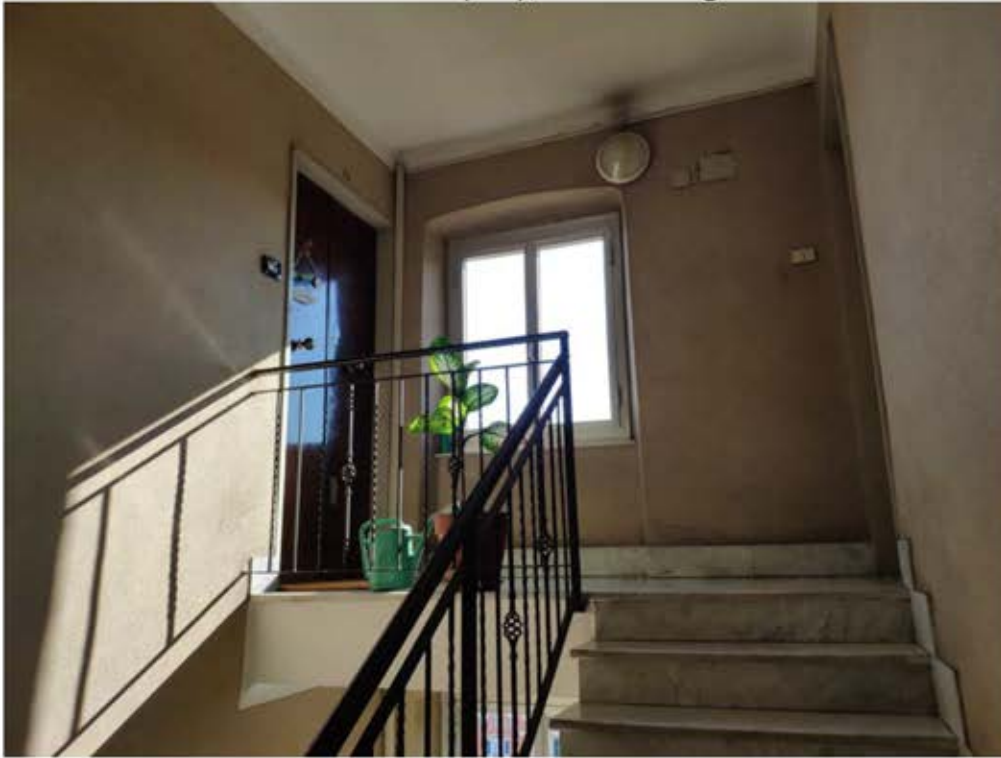
Foto n°5 – Vista accesso interno rampa finale e portoncino caposcala
