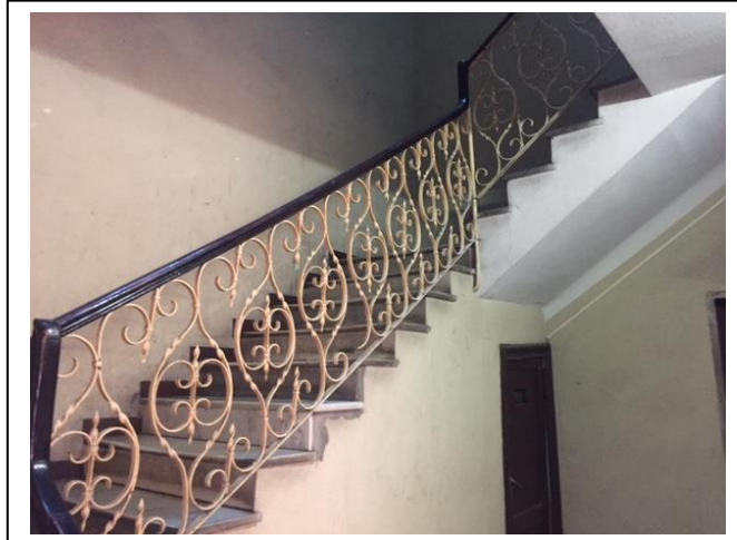
Foto n. 14 : rampa di scale da ingresso
