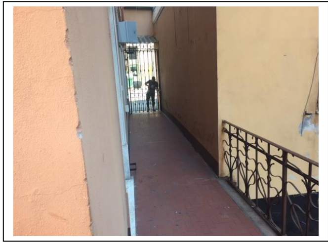
Foto n. 10 : passaggio pedonale interno verso i civv 50 e 50 A
