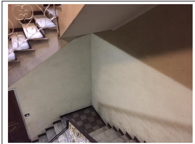
Foto n. 18 : tromba rampe del vano scale condominiale
