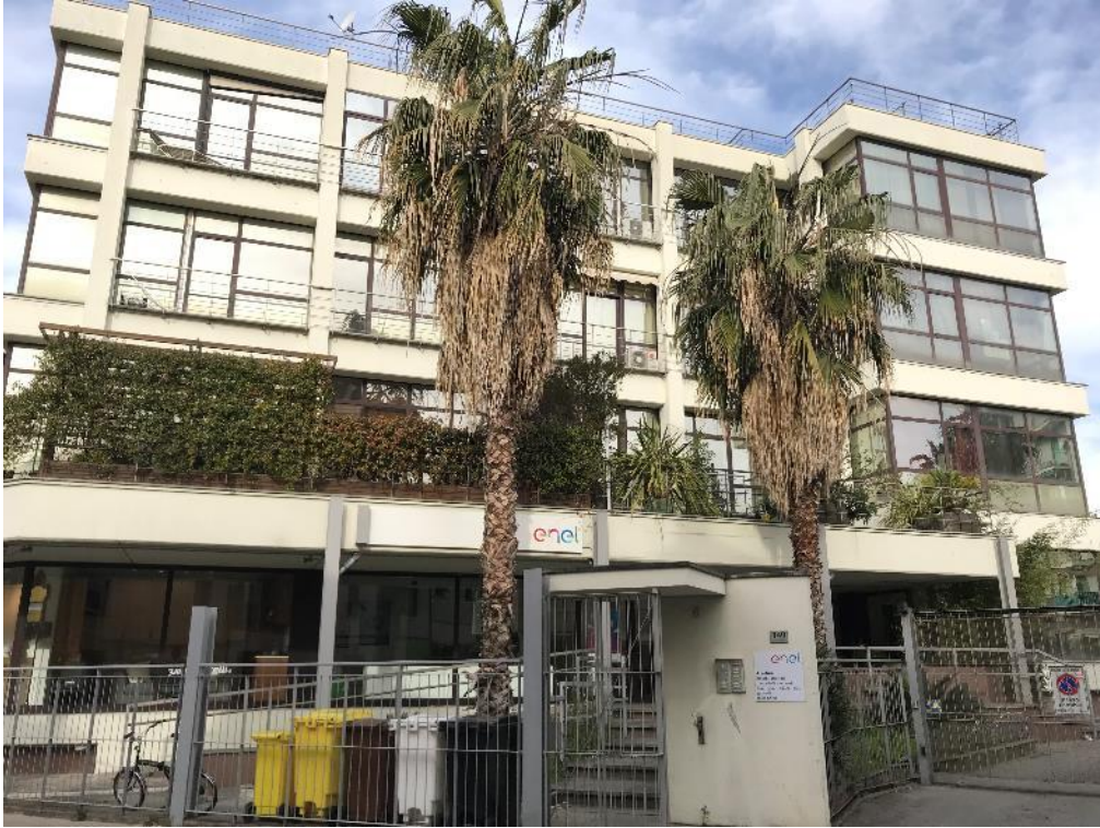
Foto n.1: Vista Esterna Edificio Via Piacenza n.149 – foto da pubblica via
