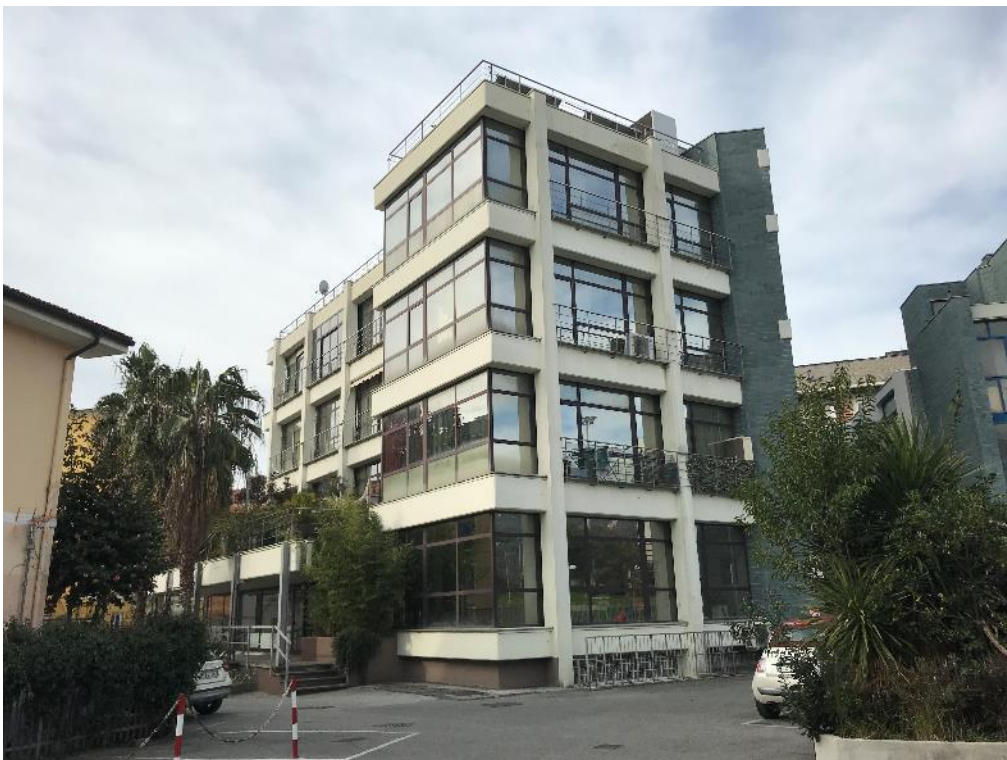
Foto n.2: Vista Esterna edificio da cortile interno
