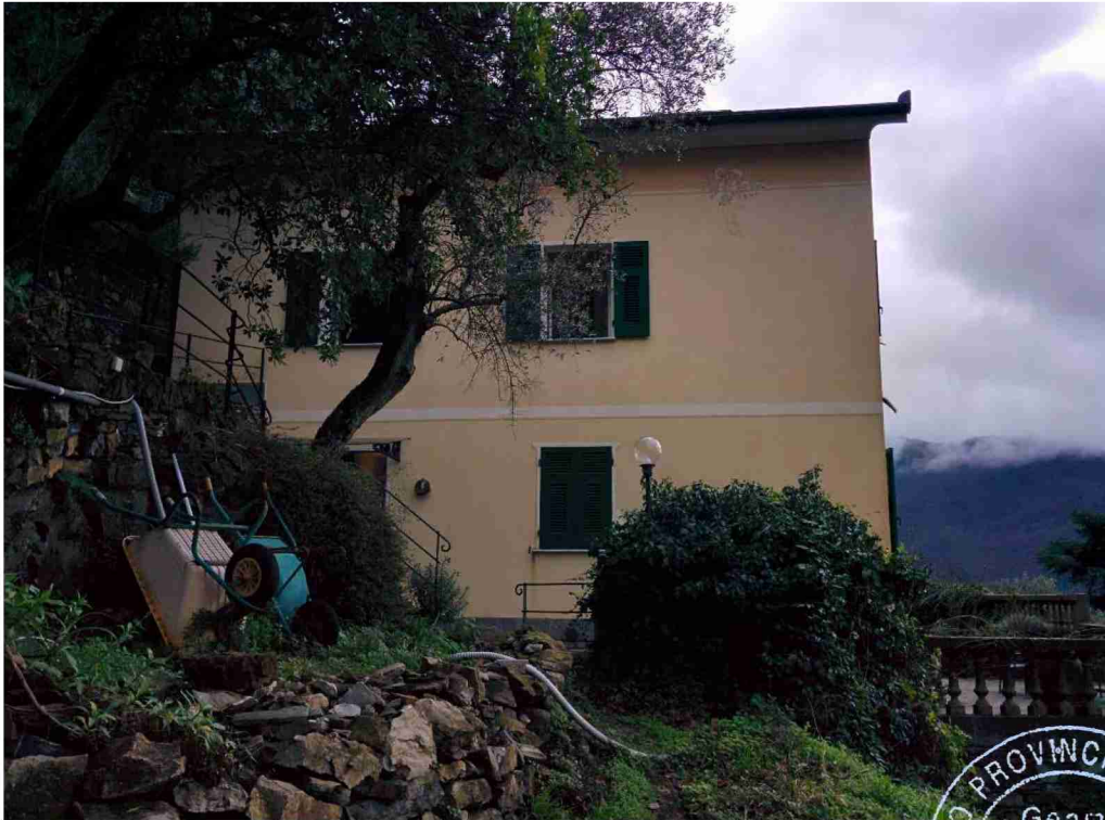
FOTO N°. 15: Prospetto Nord
