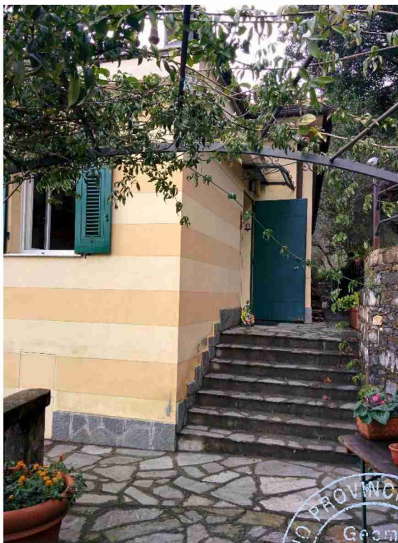
FOTO N° 21: Disimpegno posto sul retro lato Sud-Est
