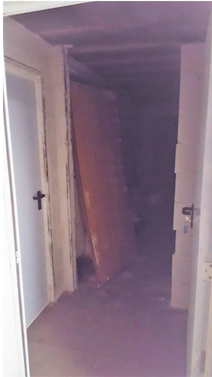
Fotografia E.5 - disimpegno in comune con sub 10
