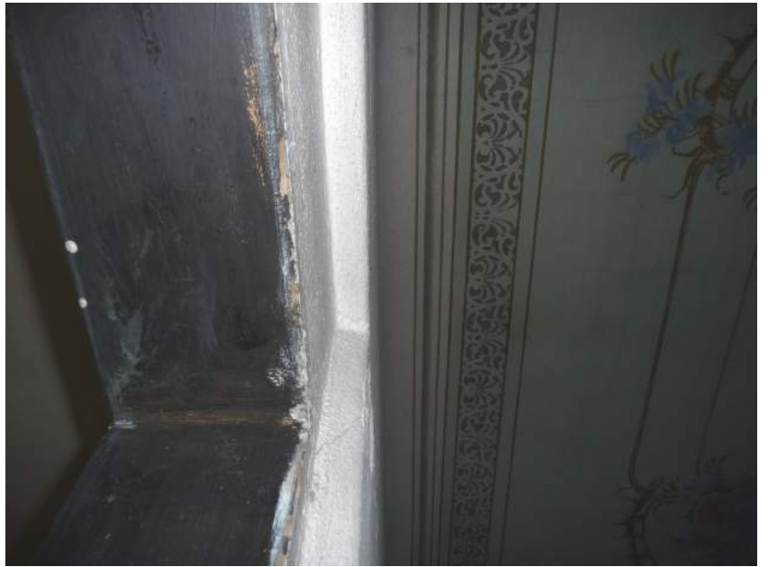
Foto 24. Pilastrate di ardesia in tutte le porte, che sono in legno
