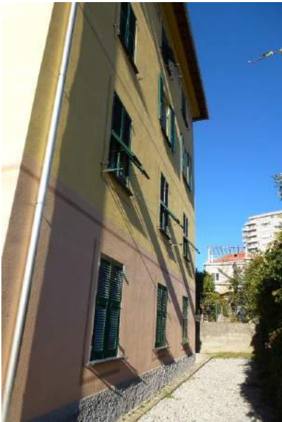
Foto 7 . Camminamento condominiale Prospetto est
