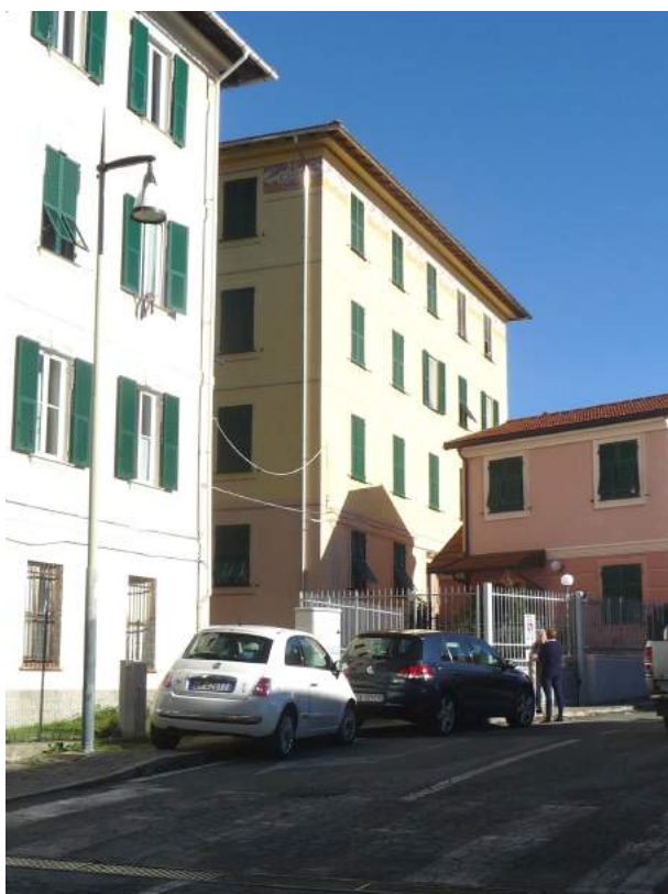
Foto 1. Prospetto sud da Via Castagnola
