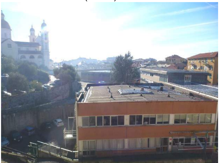
Foto 27. Vista verso sud
