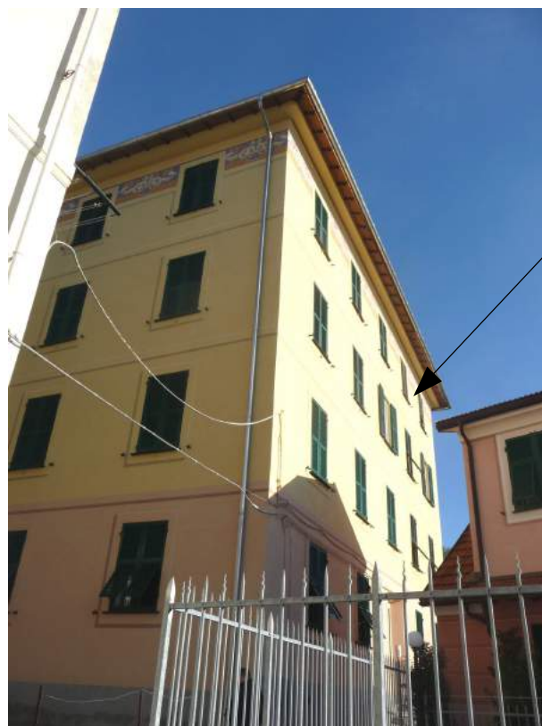
Foto 2. Verso il percorso pedonale al civ.17
