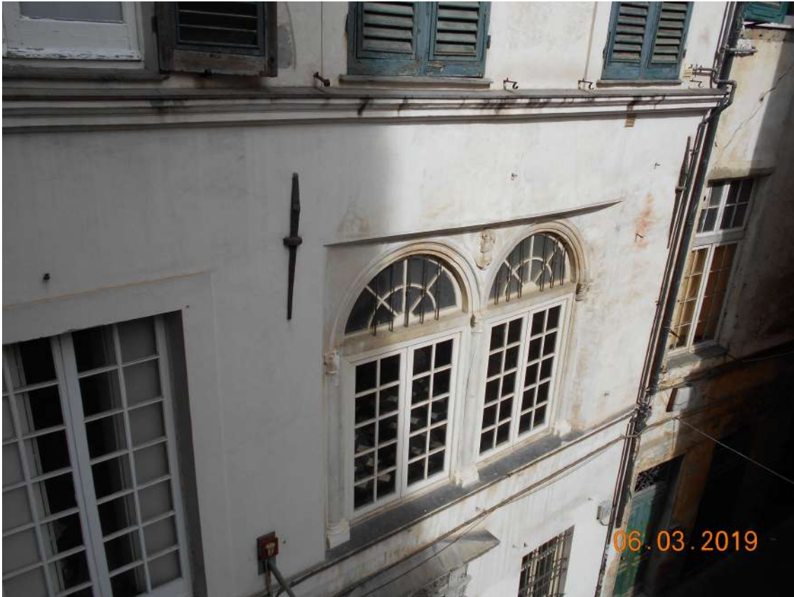
FOTO N. 19 – VISTA LATERALE CAMERA (PIAZZA DELLA LEPRE)
