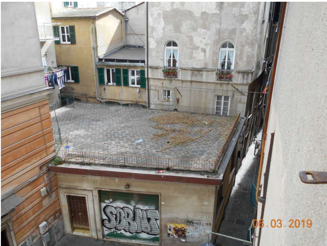
FOTO N. 20 – VISTA LATERALE CAMERA (PIAZZA DELLA LEPRE)
