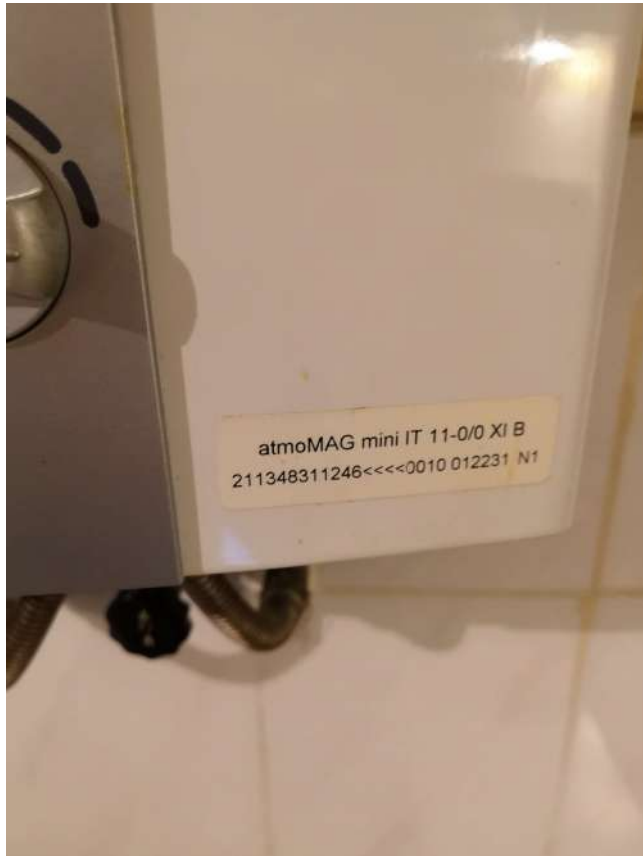
FOTO N. 30 – PARTICOLARE SCALDA BAGNO
