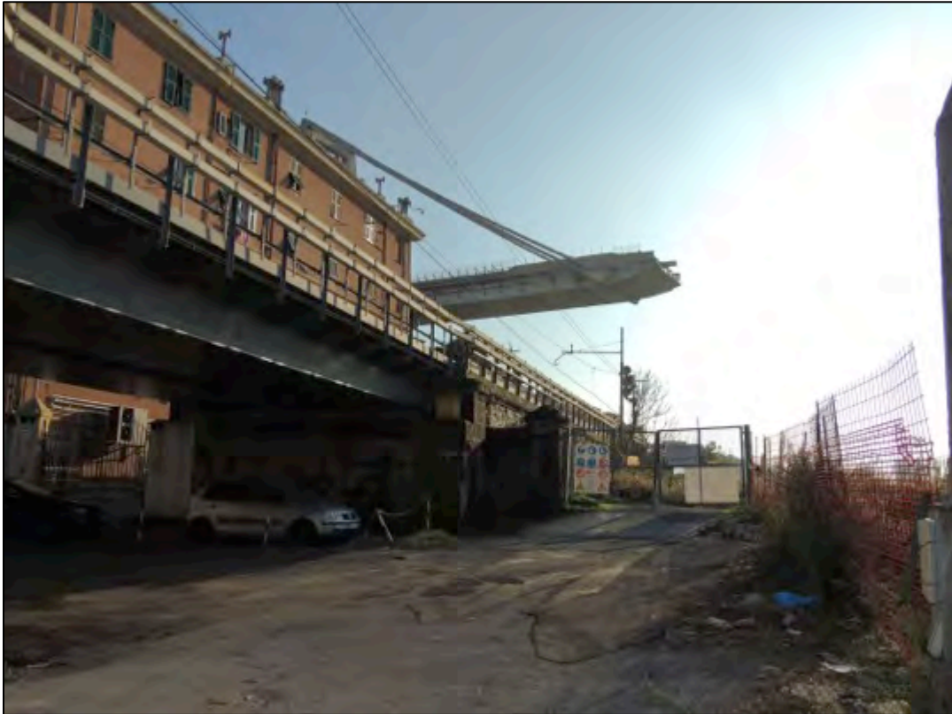
Foto 8 – il moncone del ponte Morandi all'uscita del tunnel sotto alla linea Bastioni della ferrovia
