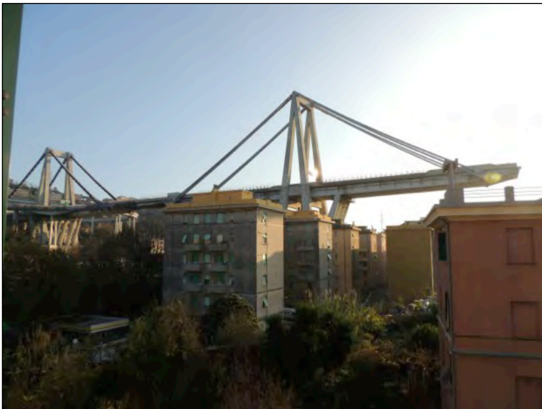
Foto 18 – vista dalla finestra della camera B sul ponte Morandi
