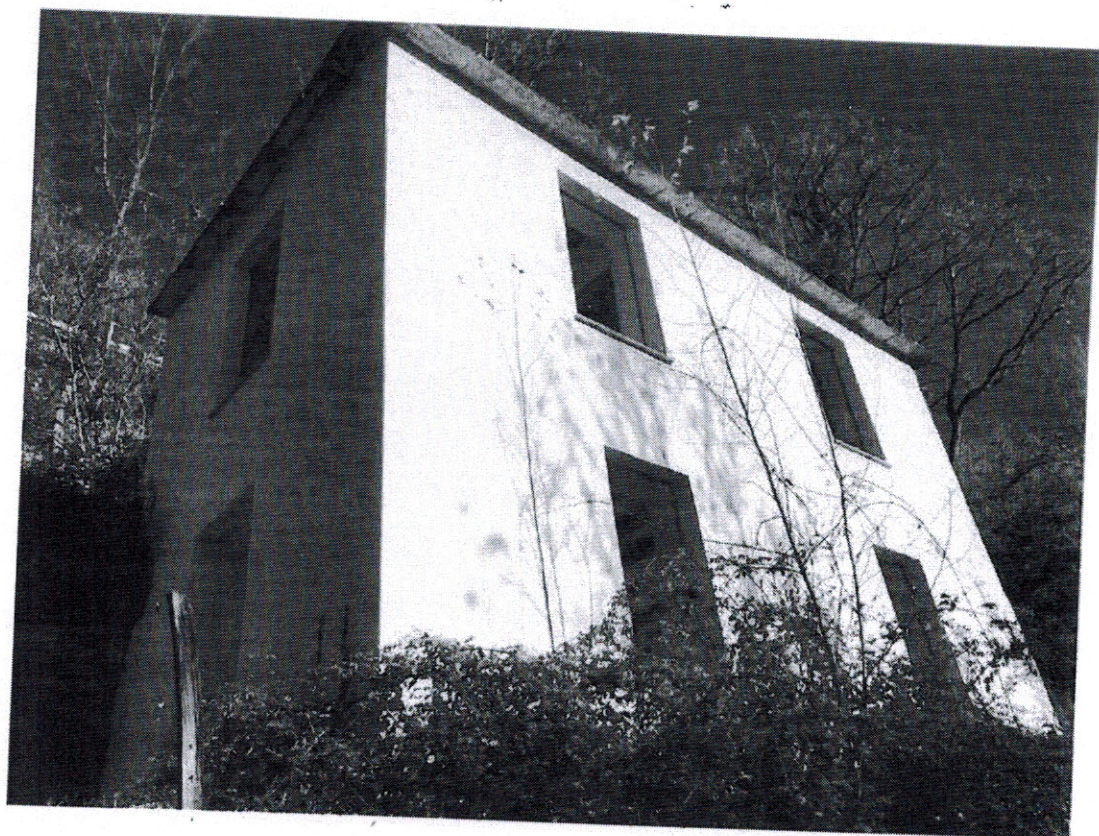
Foto 10: VEDUTA GENERALE DELL'IMMOBILE - PROSPETTO SUD-OVEST
