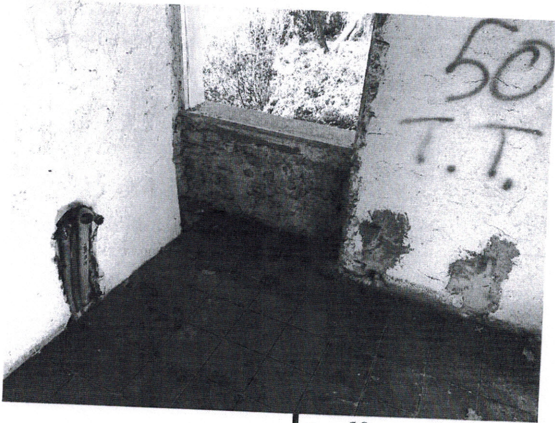
FOTO 18: BAGNO - PIANO PRIMO
