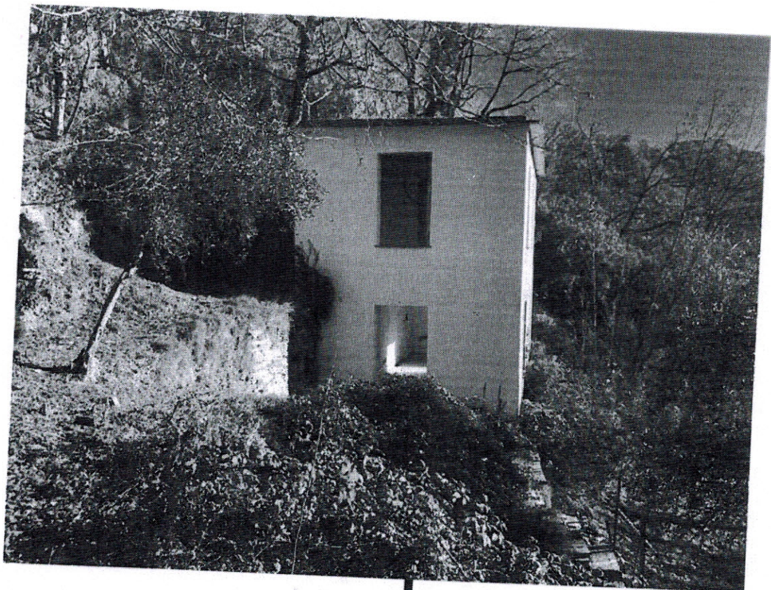
Foto 9: VEDUTA GENERALE DELL'IMMOBILE - PROSPETTO OVEST
