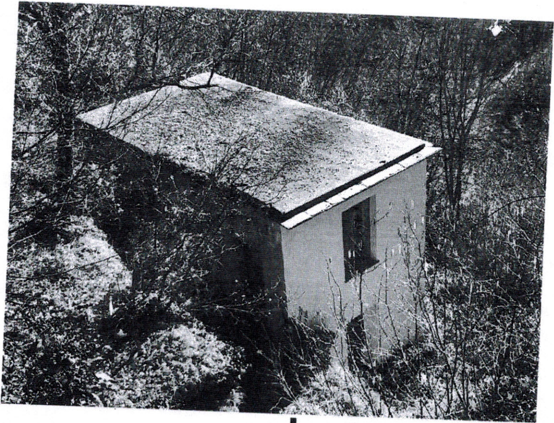
Foto 1: VEDUTA GENERALE DELL'IMMOBILE OGGETTO DI STIMA - PROSPETTO NORD- OVEST
