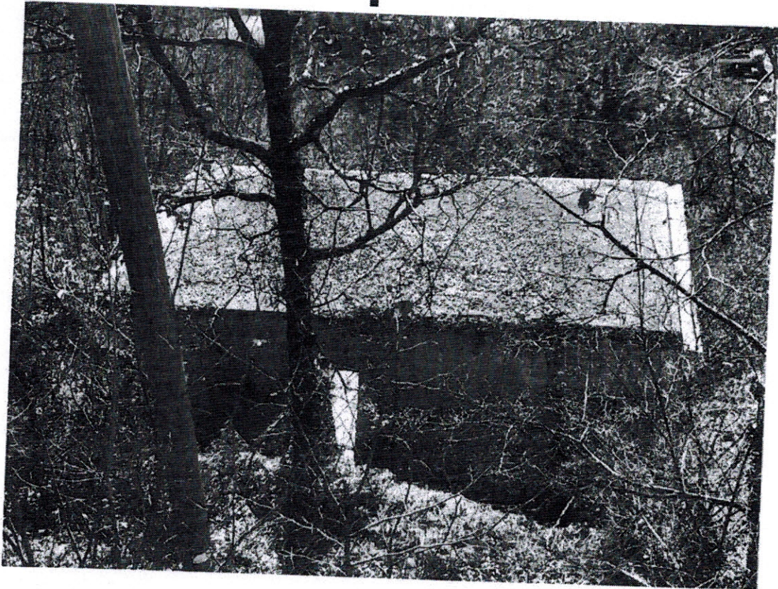
Foto 2: VEDUTA GENERALE DELL'IMMOBILE OGGETTO DI STIMA - PROSPETTO NORD
