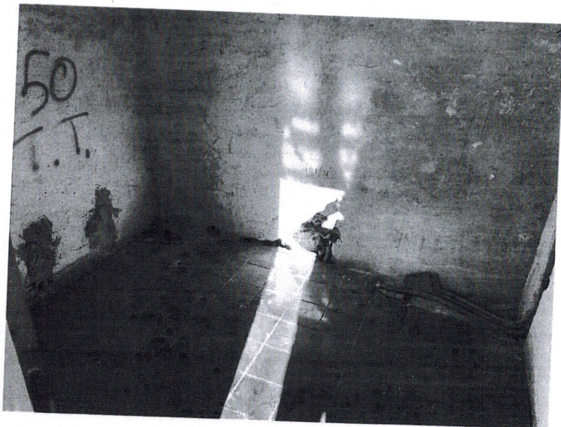
Foto 18: BAGNO - PIANO PRIMO
