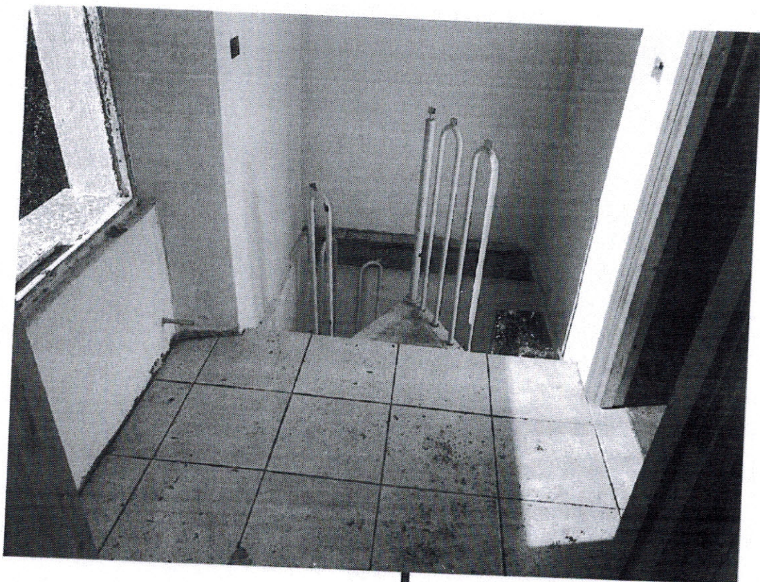
Foto 17: SCALA DI COLLEGAMENTO CON IL PIANO TERRA - PIANO PRIMO
