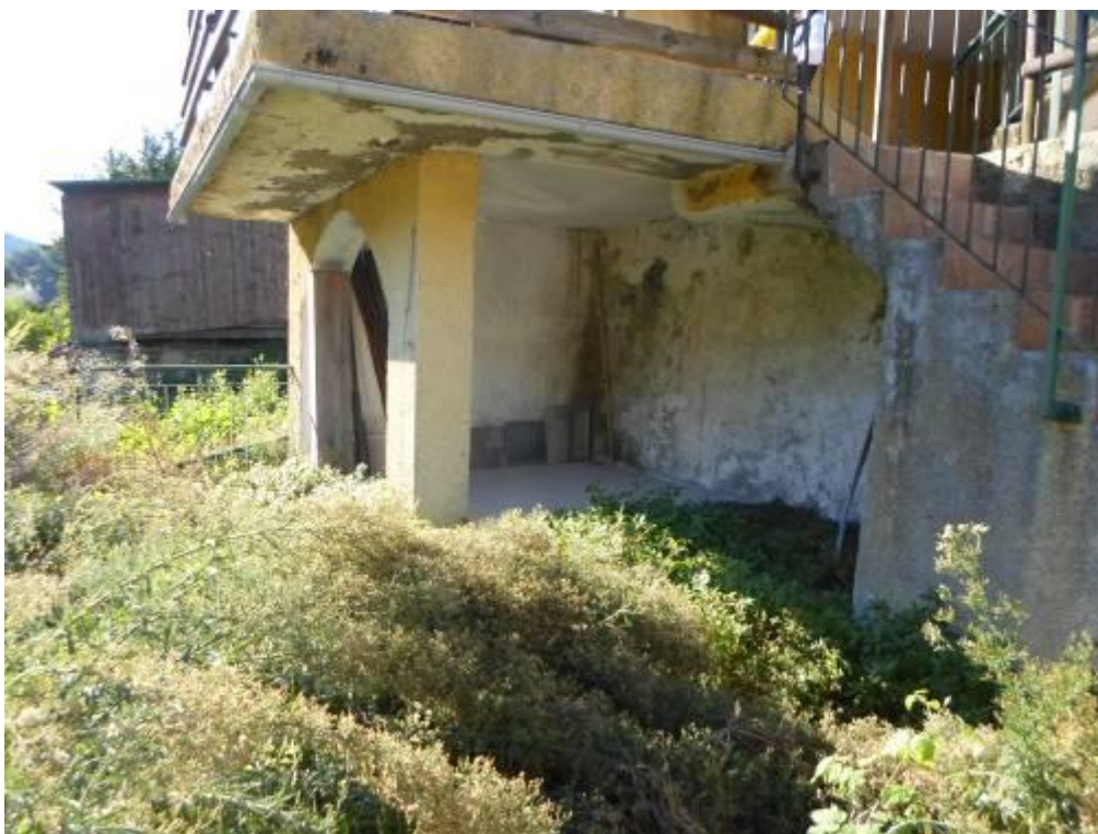
FOTO N. 17 Ripresa del deposito.
