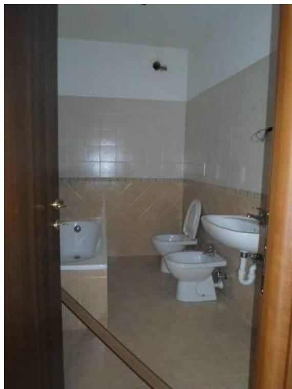
FOTO N. 7 Ripresa del bagno al piano terreno.
