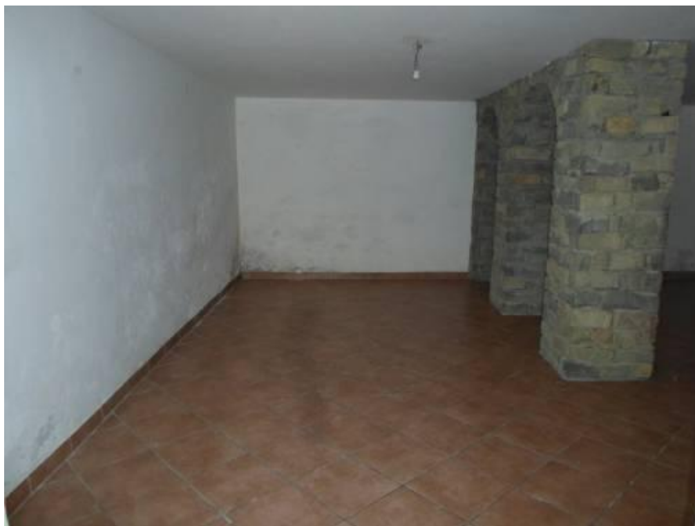
FOTO N. 12 Vista della cantina al piano seminterrato.
