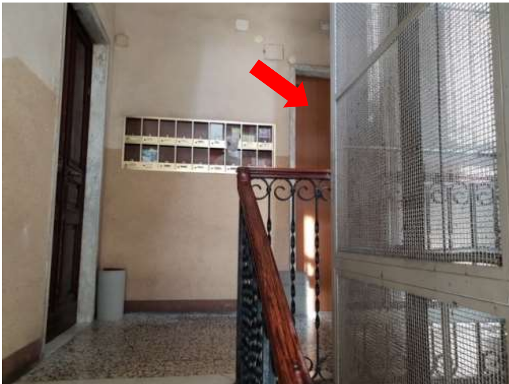
FOTO 10—PIANEROTTOLO DI INGRESSO
