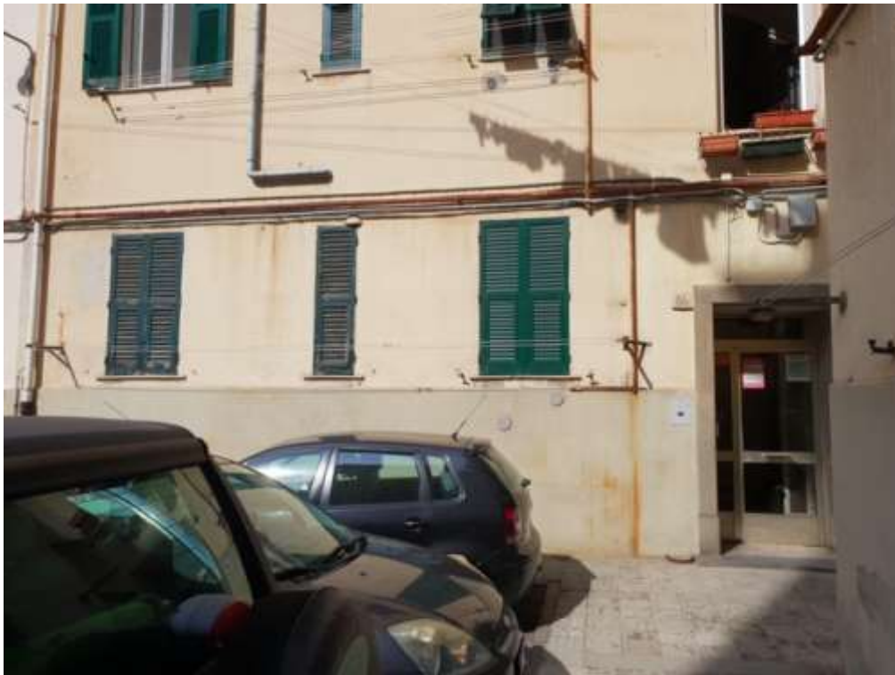
FOTO 1—PORTONE DI ACCESSO ALLA SCALA
