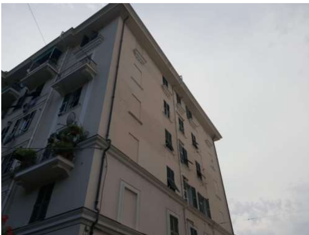
FOTO 8—PARTE SUPERIORE FACCIATA SU VIA CAPELLO
