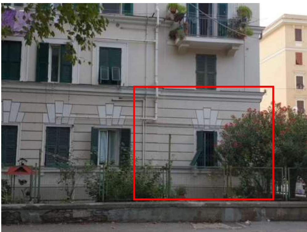
FOTO 4— PARTICOLARE PROSPETTO SU VIA FILLAK
