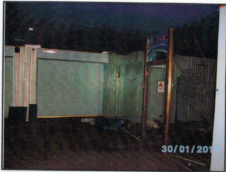
FOTO N.25 - PIANO PRIMO PANORAMICA SECONDO LOCALE
