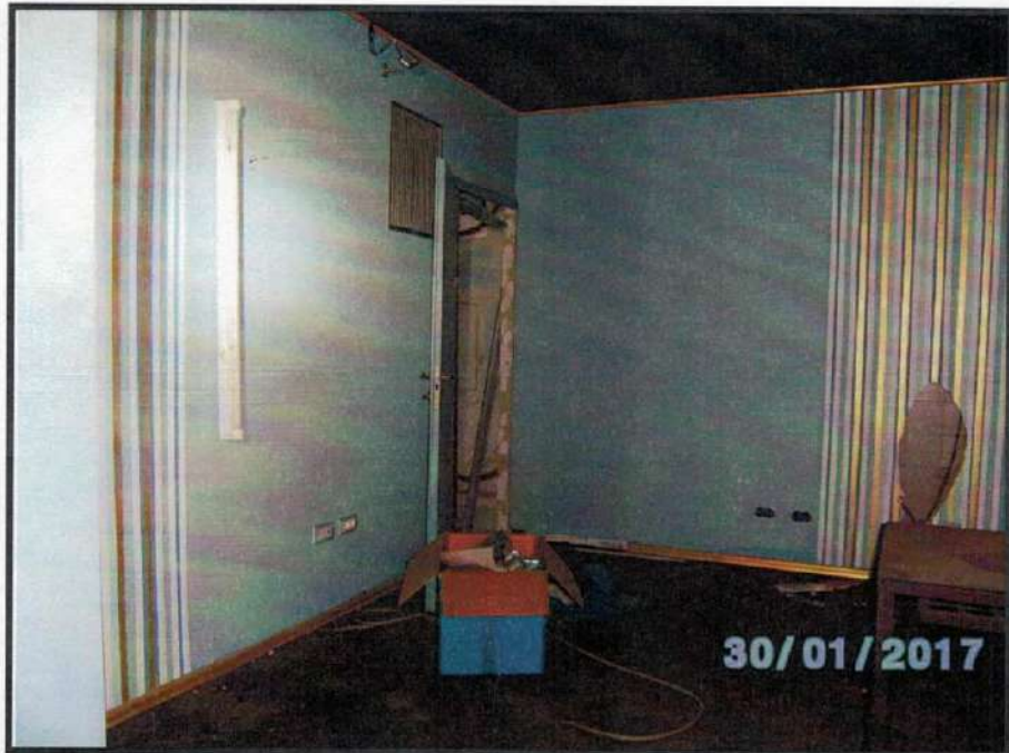
FOTO N.30 - PIANO PRIMO SECONDO LOCALE
