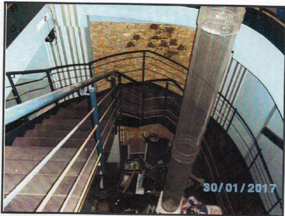
FOTO N.7 - SCALA DI ACCESSO AL PIANO PRIMO
