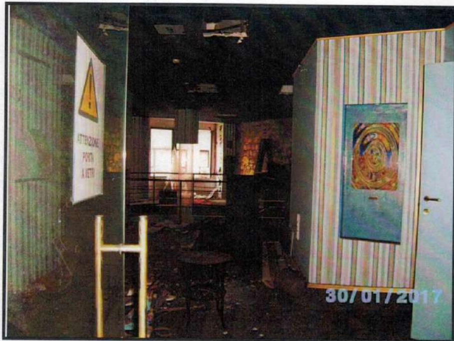
FOTO N.24 - PIANO PRIMO PANORAMICA PRIMO LOCALE
