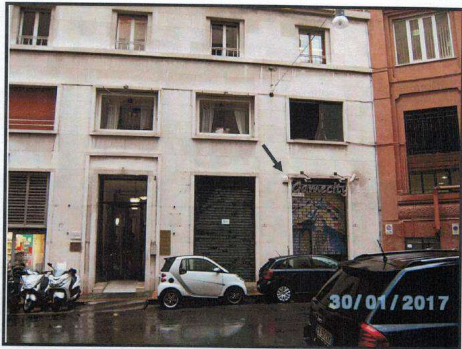
FOTO N.1 - INGRESSO LOCALE VIA CARDUCCI 1 ROSSO
