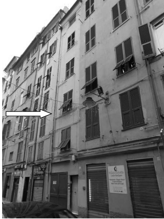
Fotografia n. 1 – vista esterna del caseggiato
