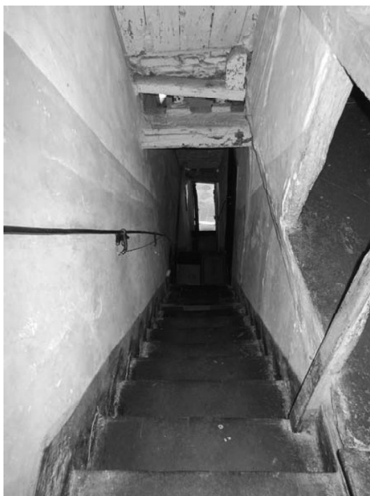
Fotografia n. 4 – vano scala condominiale
