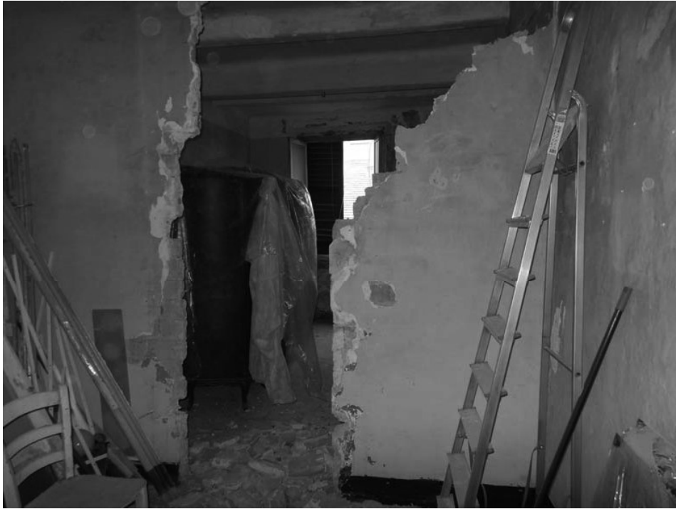
Fotografia n. 15 – vano con affaccio su via del Molo
