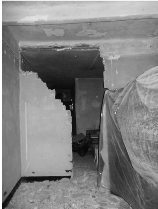
Fotografia n. 16 – vano con affaccio su via del Molo
