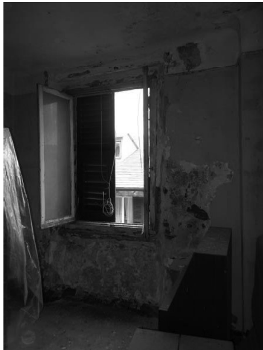
Fotografia n. 18 – vano con affaccio su via del Molo
