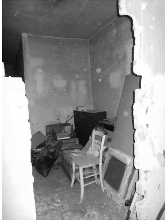
Fotografia n. 17 – vano con affaccio su via del Molo
