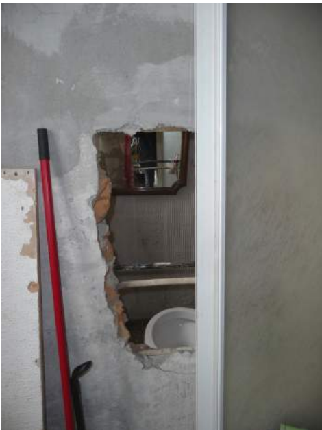
Foto 25. Cucina – foro su bagno
