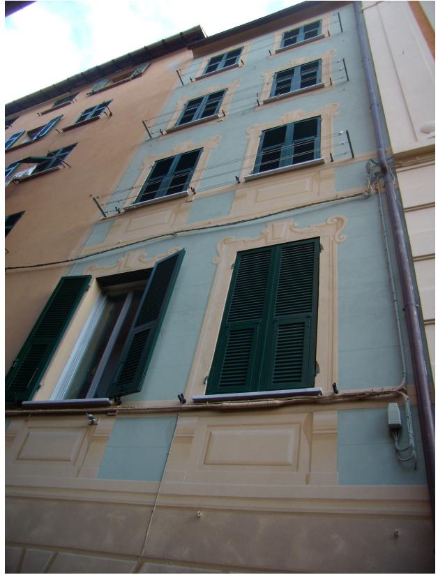
foto 1 – La facciata su via Beata Chiara
