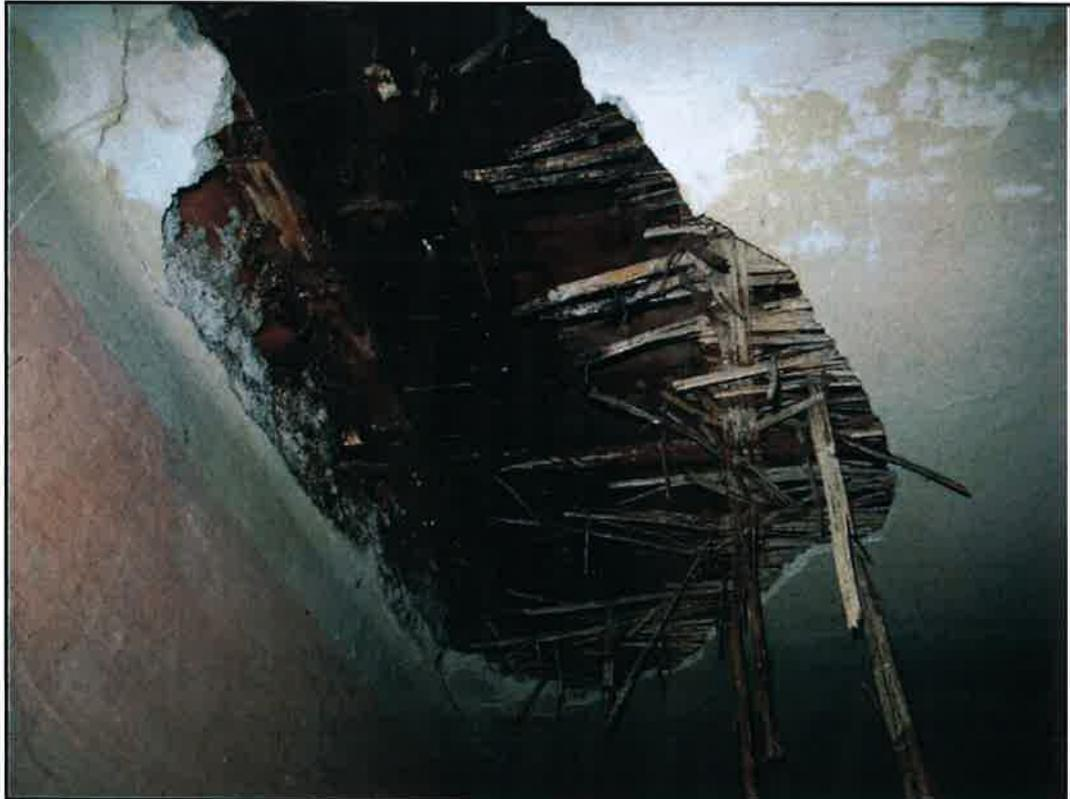
**Foto 16 – camera sud/ovest – particolare soffitto crollato**
