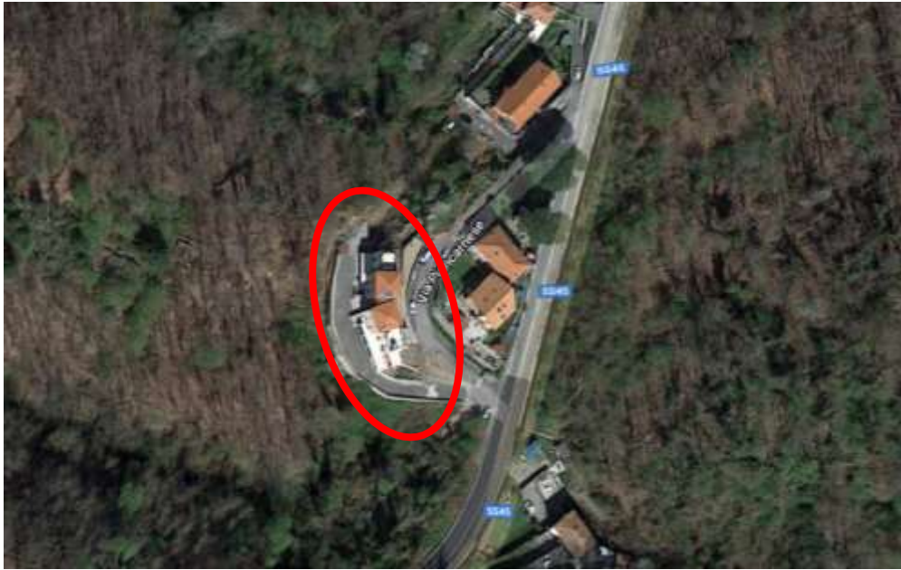
Particolare fabbricati in costruzione oggetto di stima
