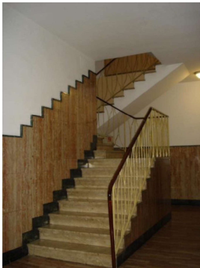
Particolare vano scala C
