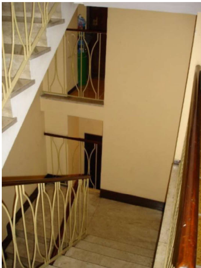
Particolare vano scala C
