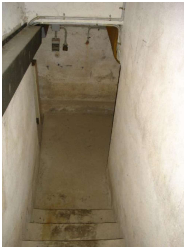
Scale di accesso alle cantine
