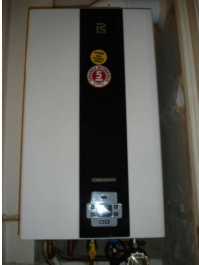
Particolare del generatore di calore (installato in cucina)
