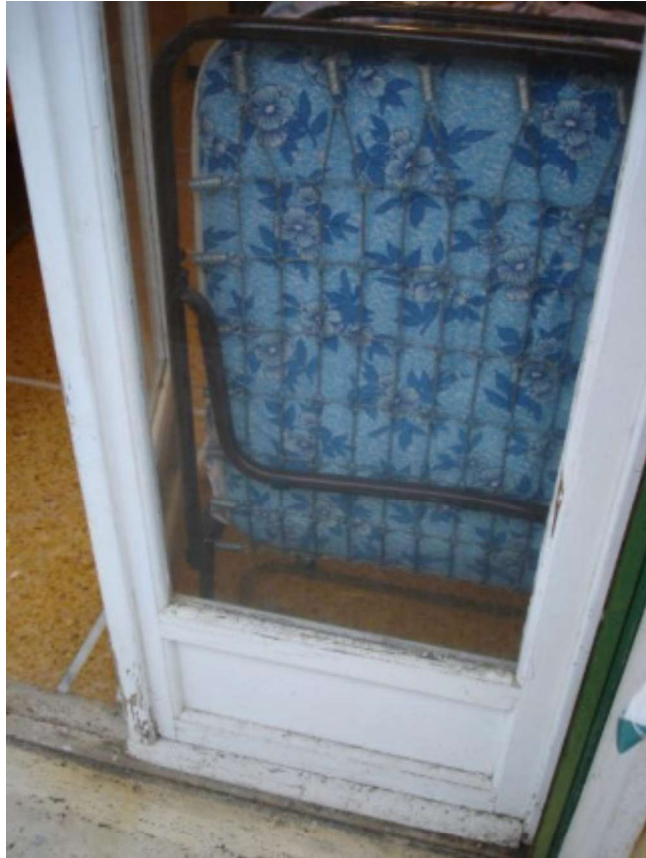
Particolare della porta finestra del soggiorno
