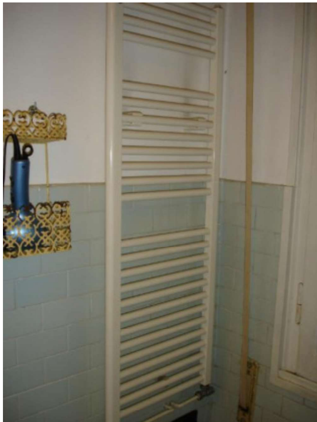
Particolare elementi radianti bagno
