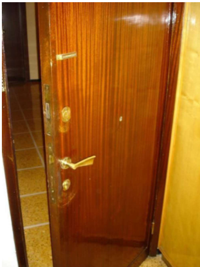
Particolare del portoncino d'accesso all'appartamento (dall'interno)
