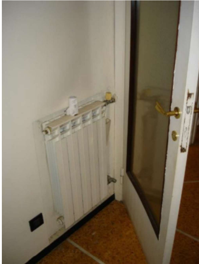
Particolare elementi radianti
