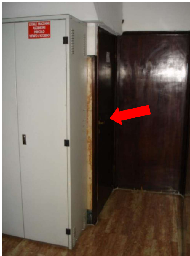
Particolare porta di accesso alle cantine
