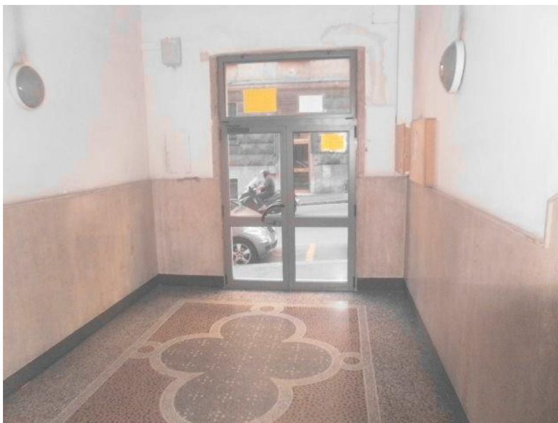
FOTO N° 3-4 - PORTONE E ATRIO CONDOMINIALE
