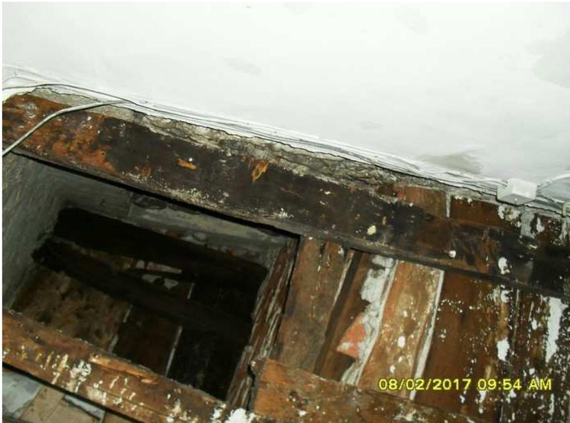
Foto 5: Cedimento del soffitto del vano scala
