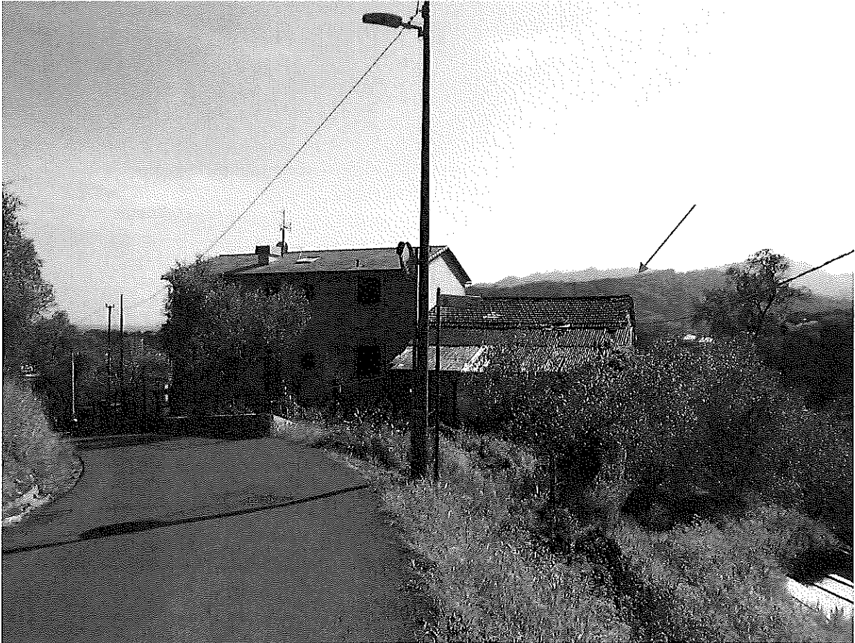
Foto 7 – Vista dell'edificio da Via Cerisola
