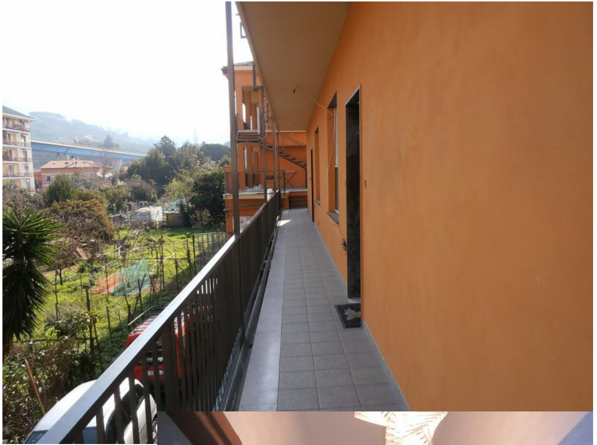
BALLATOIO E PORTA D'ACCESSO
