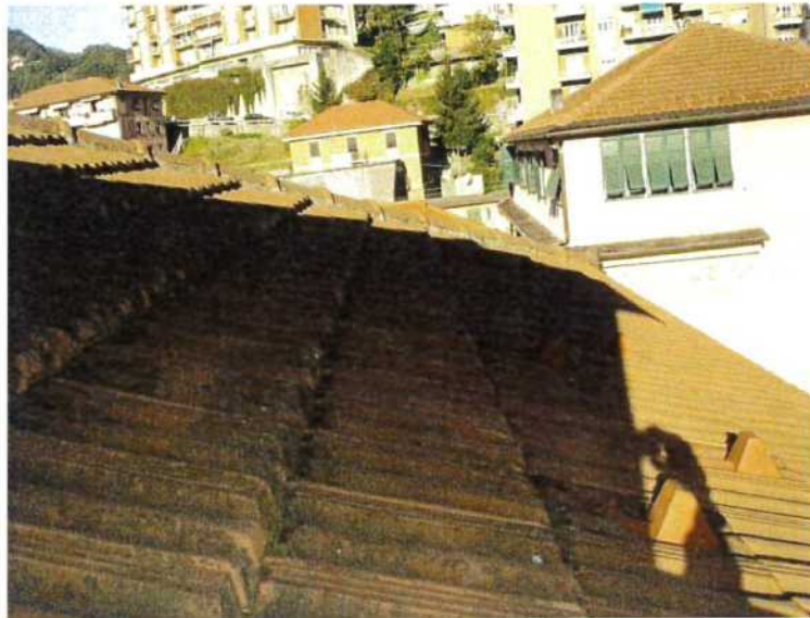
Vista della copertura del tetto
