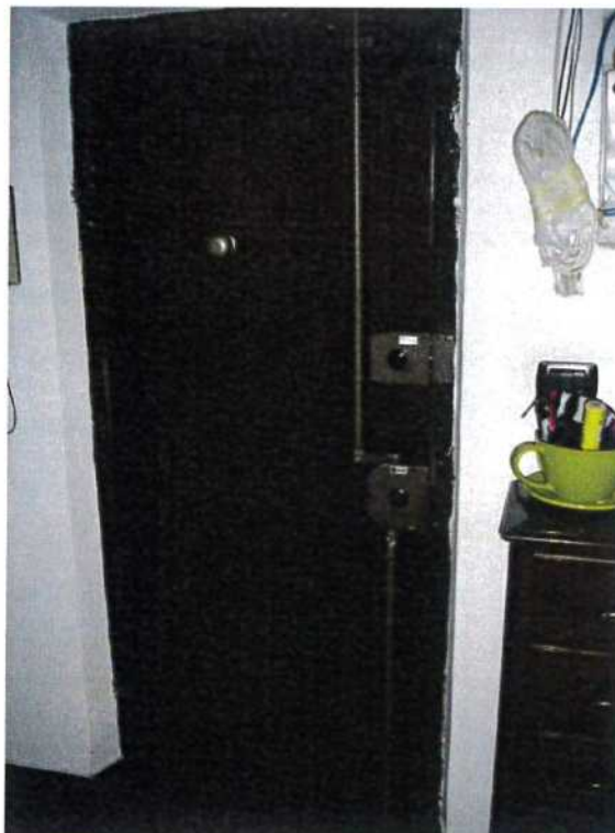
Particolare del portoncino d'accesso all'appartamento (dall'interno)
