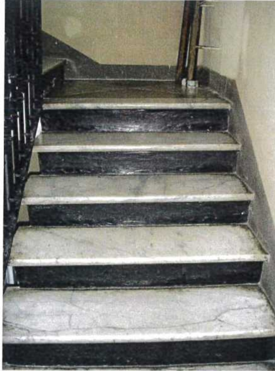
Particolare vano scala
