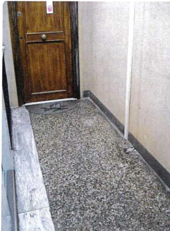
Particolare pianerottolo condominiale e porta di ingresso all'appartamento
