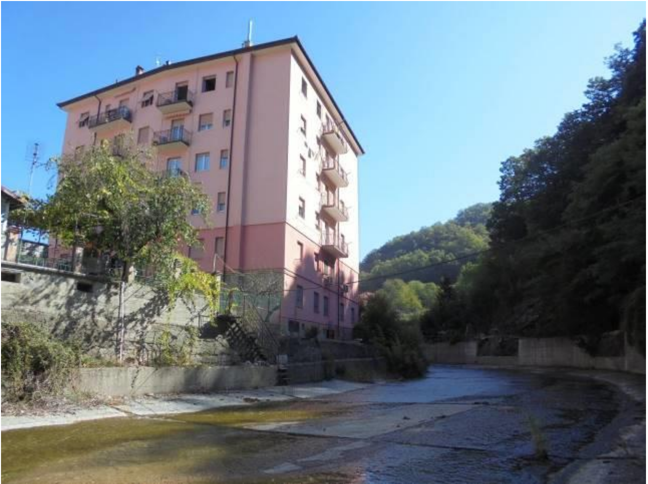
Foto 5 – Il condominio di Via Don Domenico Minetti, 44 visto dall'alveo del Torrente Berlino
