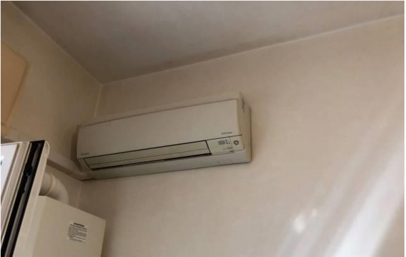
Foto 13 – dettaglio dell'unità interna di climatizzazione della cucina
