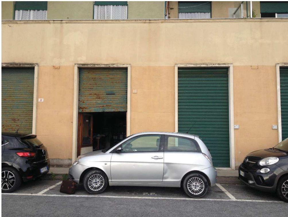
FOTO 7 - L'INGRESSO DEL MAGAZZINO
