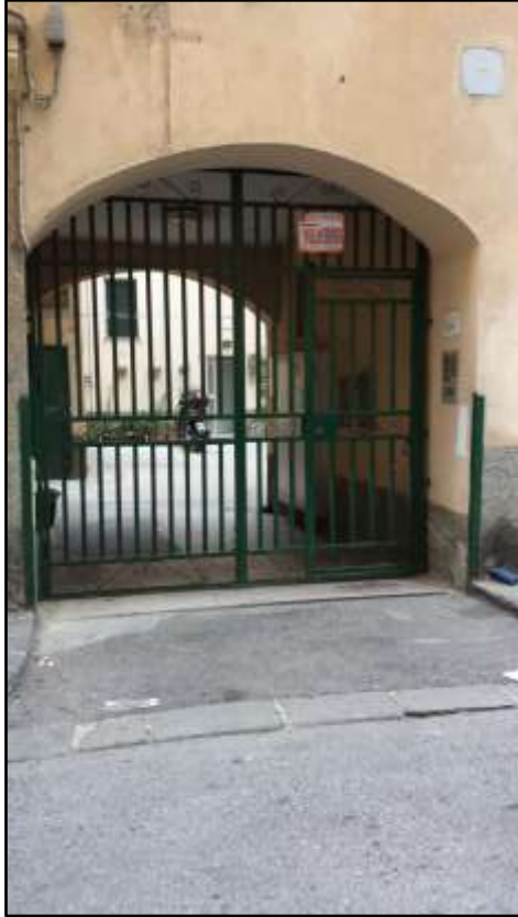
Foto 1 Accesso al cortile
