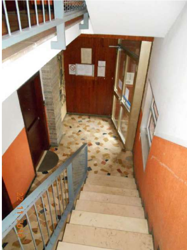
FOTO N. 5 – VANO SCALA CIV. 58
