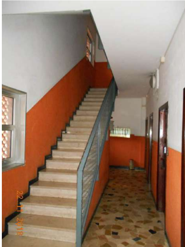
FOTO N. 4 – VANO SCALA CIV. 58
