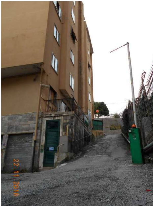
FOTO N. 21 – DISCESA ESTERNA PER ACCESSO A CANTINE
