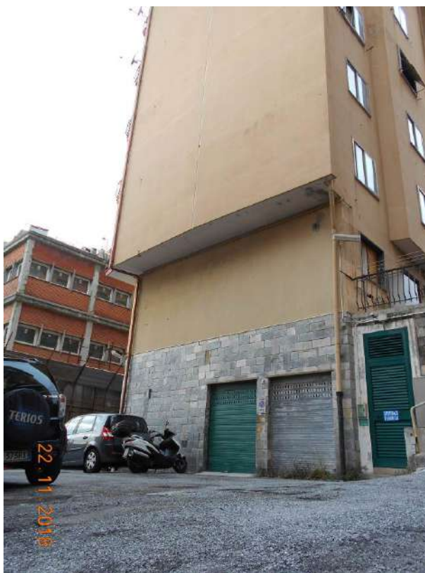
FOTO N. 22 – PERCORSO PER ACCESSO A CANTINE
