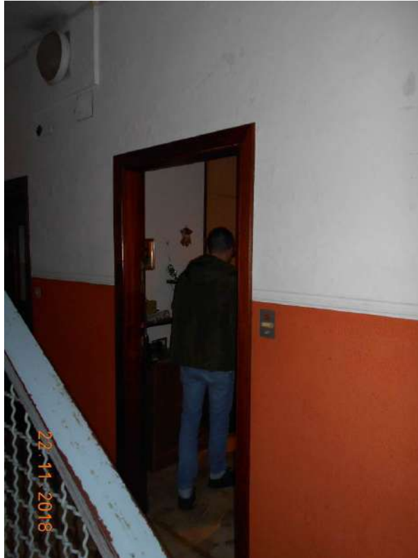
FOTO N. 6 – PORTA DI INGRESSO AD INT. 8
