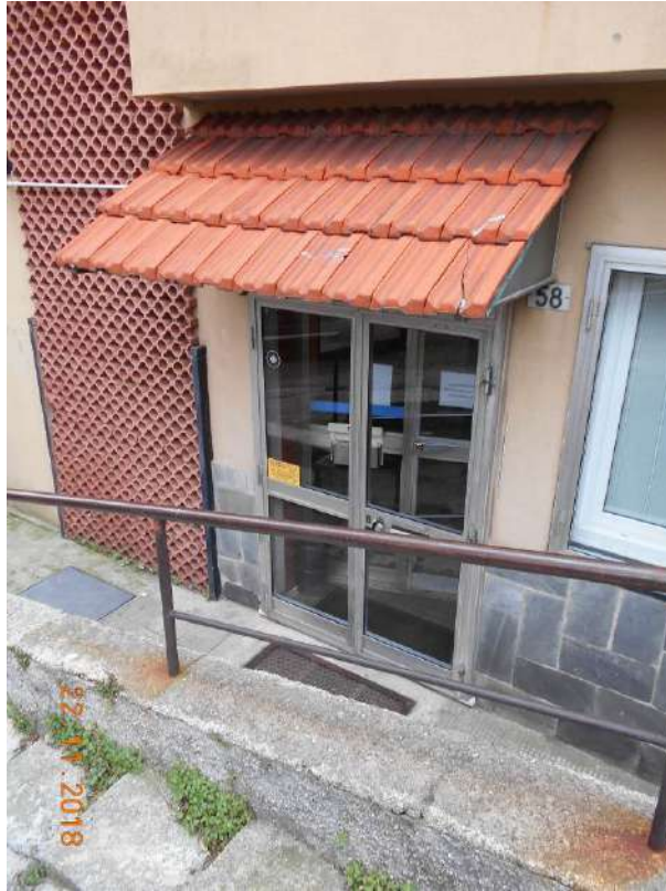
FOTO N. 3 – PORTONE DI ACCESSO AL CIV. 58
