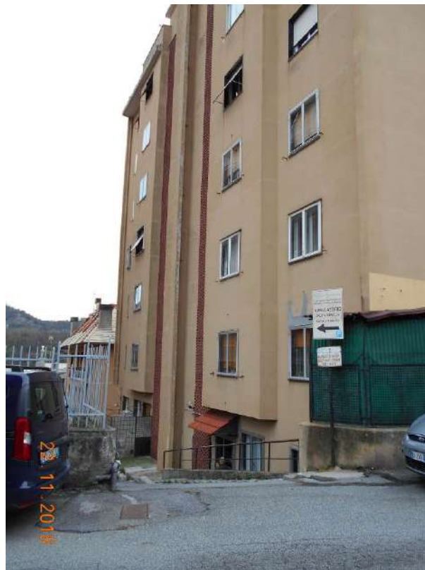
FOTO N. 2 – DISCESA DI ACCESSO AL CIV. 58
