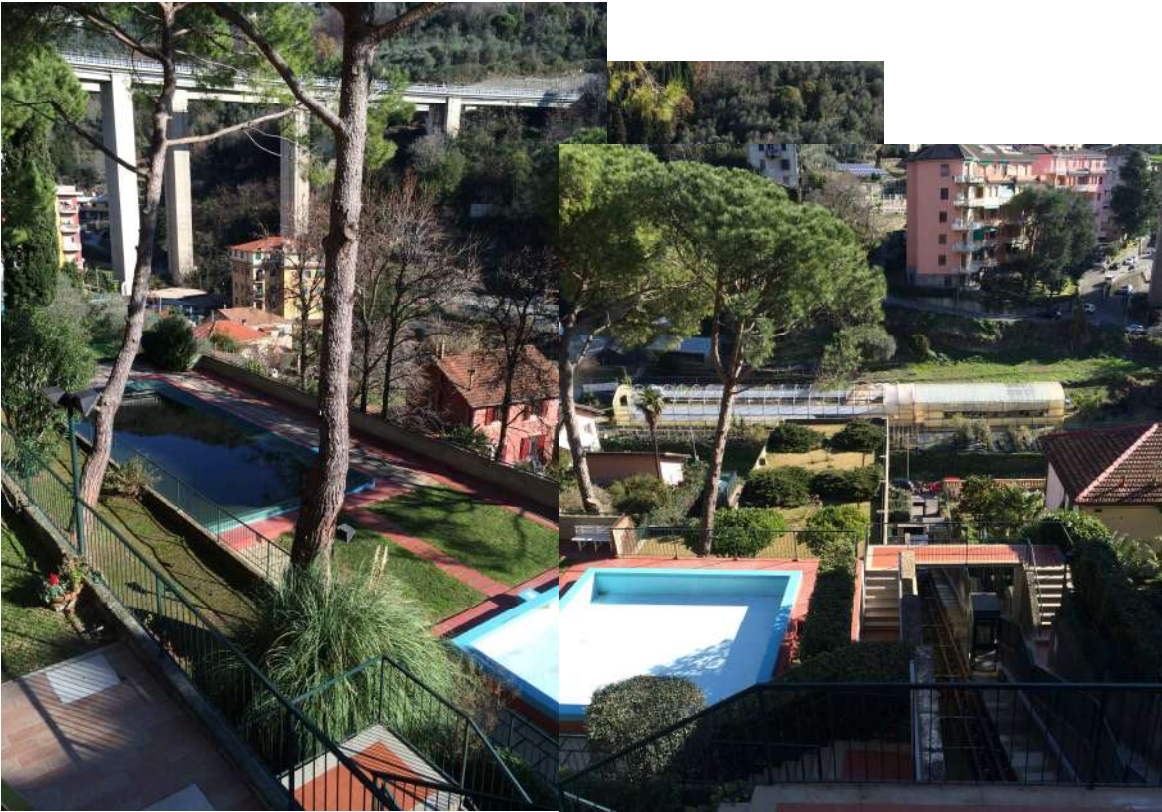
Vista dall'alto dell'ascensore inclinato e delle piscine condominiali.
