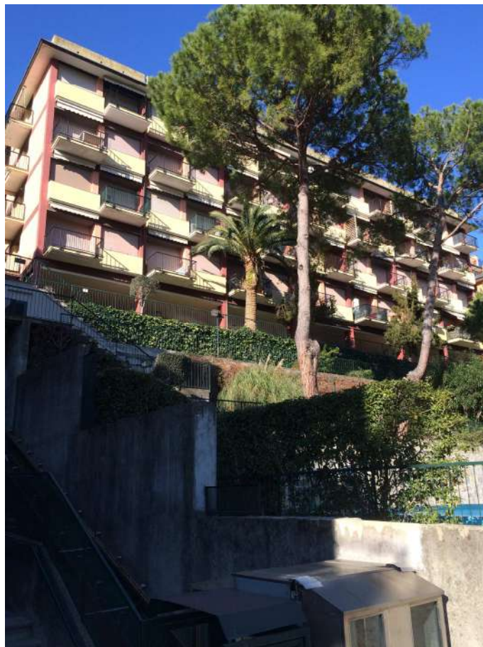
Vista dell'edificio "Bianca Saturno" in cui si trova l'appartamento periziando.
