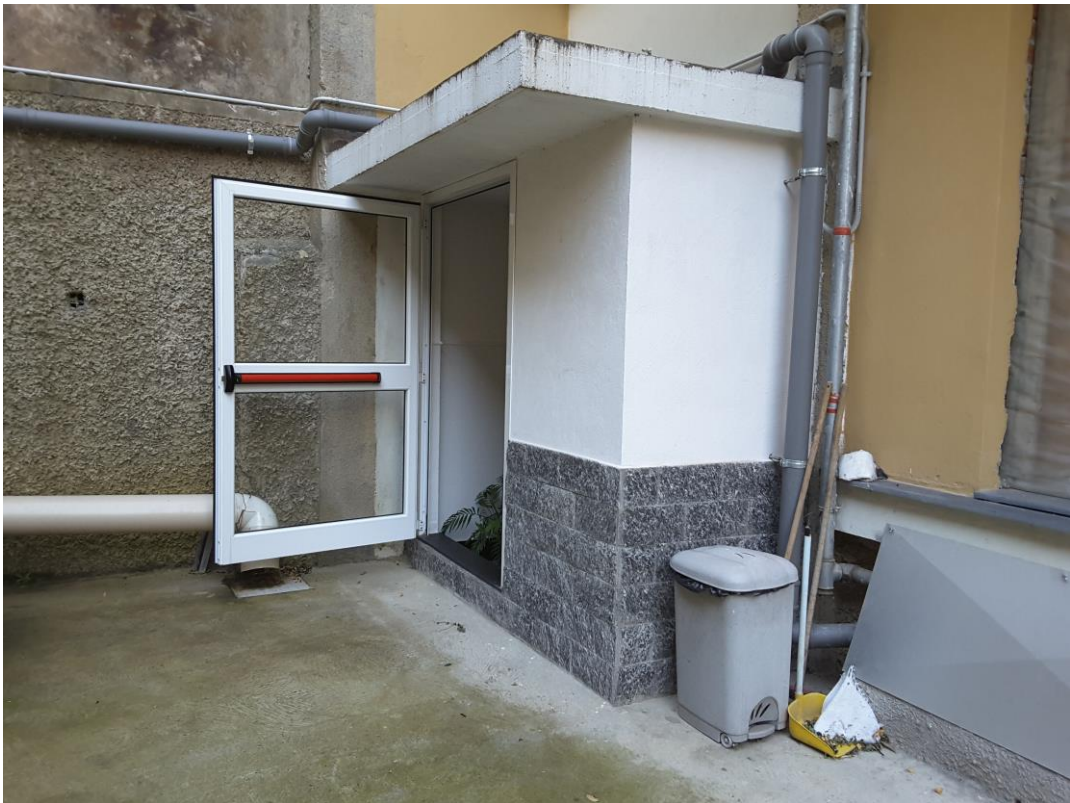
Ingresso sul distacco condominiale (civ. 93 di via Tofane)
