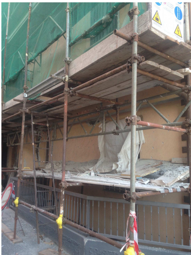
Facciata in manutenzione
