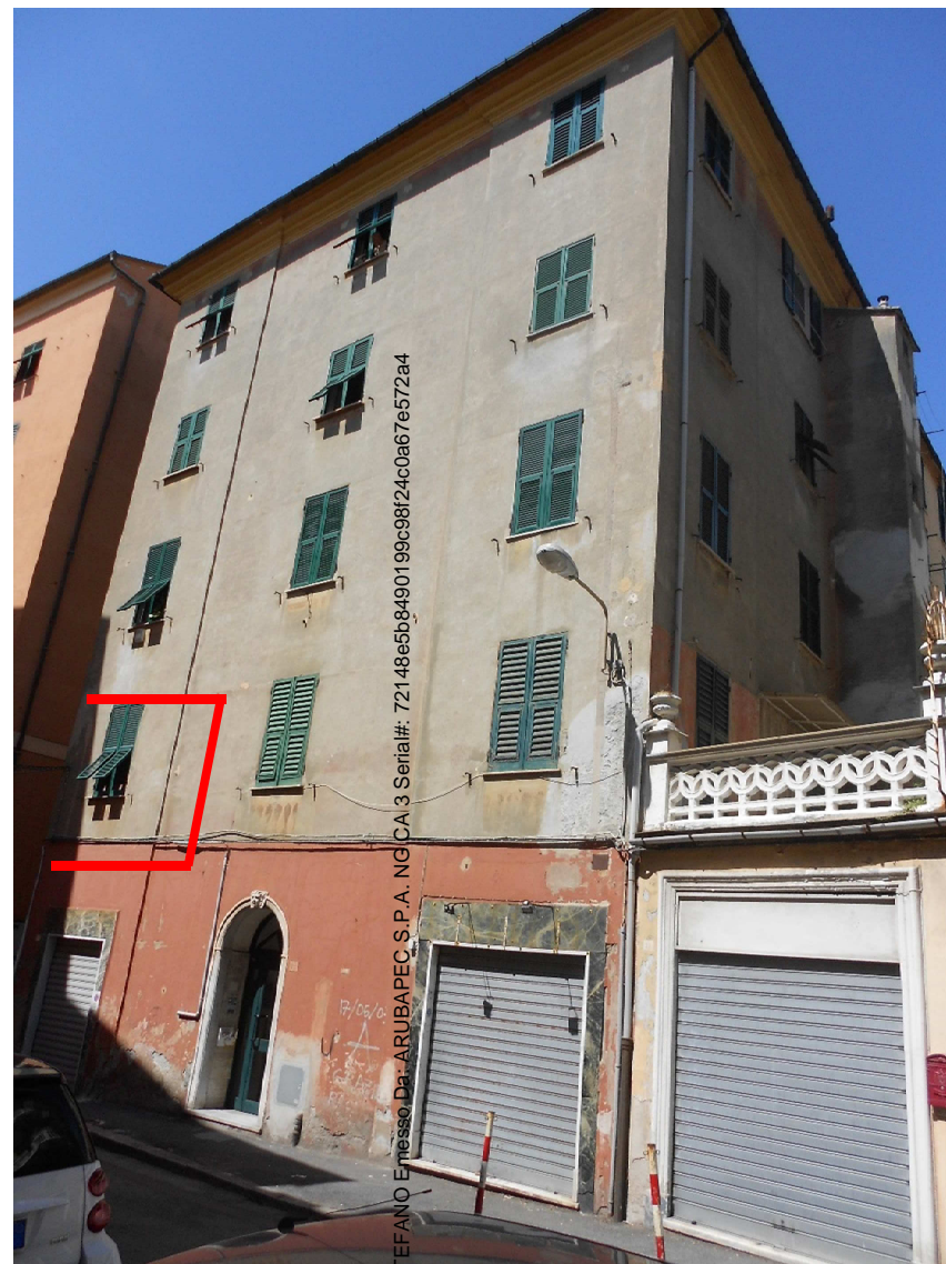
FOTO N.° 1: Prospetto SUD/EST, con indicazione dell'appartamento
