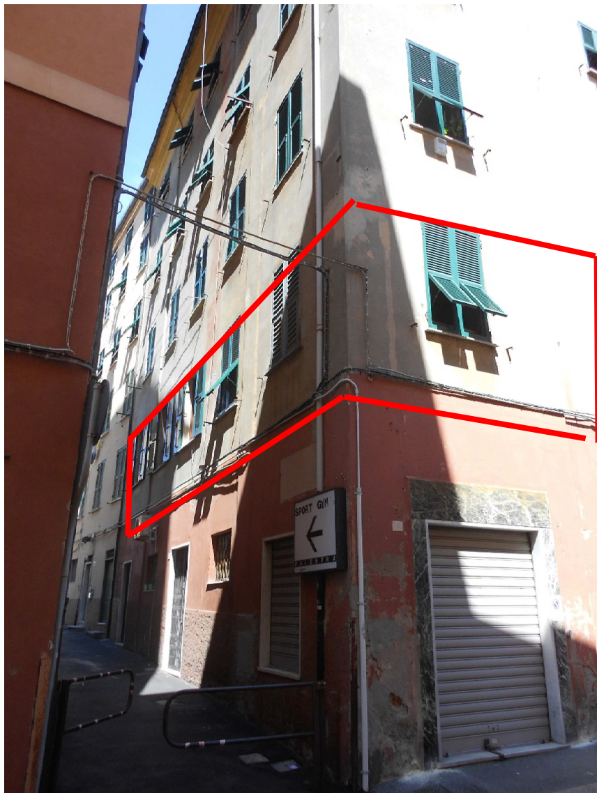
FOTO N.° 2: PROSPETTO SUD/OVEST, con indicazione dell'appartamento
