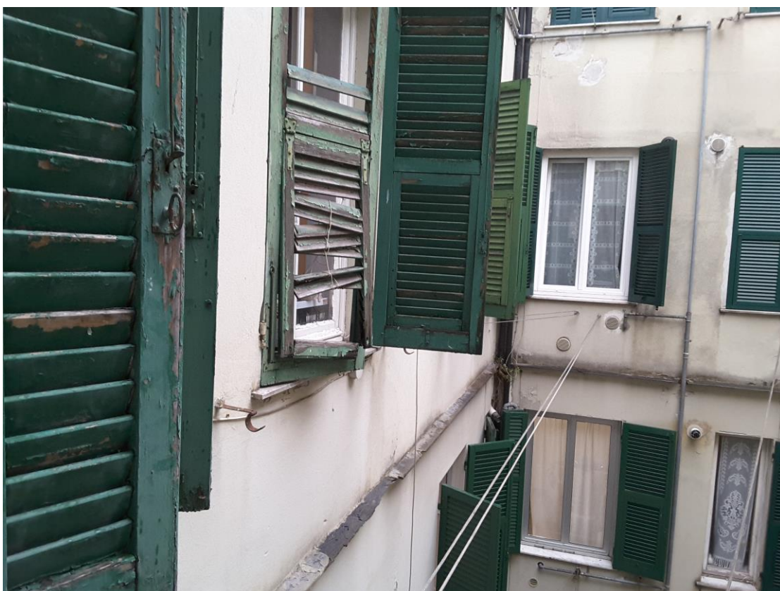
22. Affaccio sul cortile condominiale
