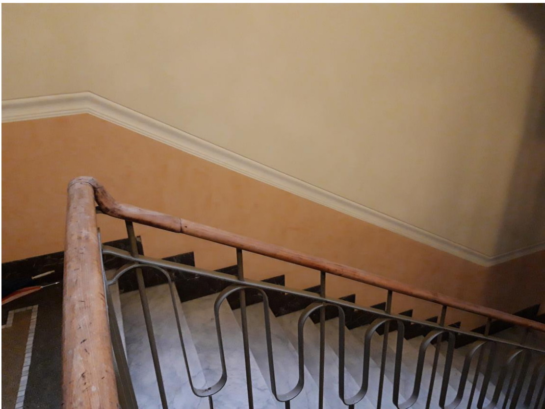
12. Particolare della ringhiera del vano scala
