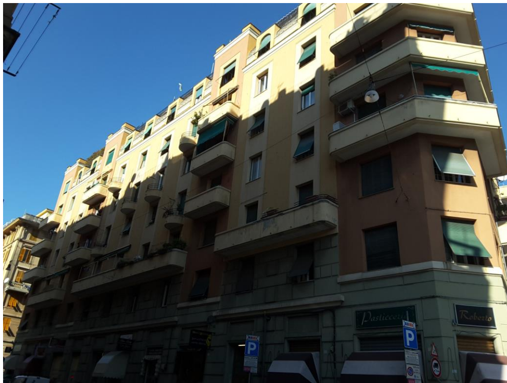
1. Prospetto sud, su via Pietro Toselli
