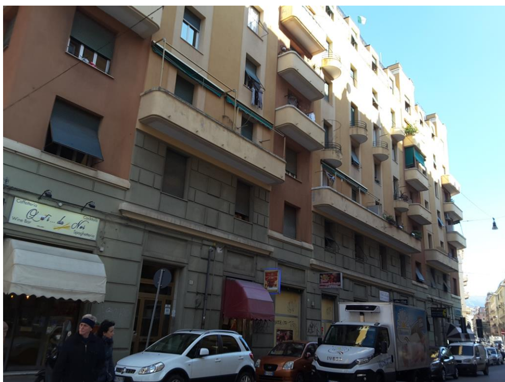
2. Prospetto sud, su via Pietro Toselli
