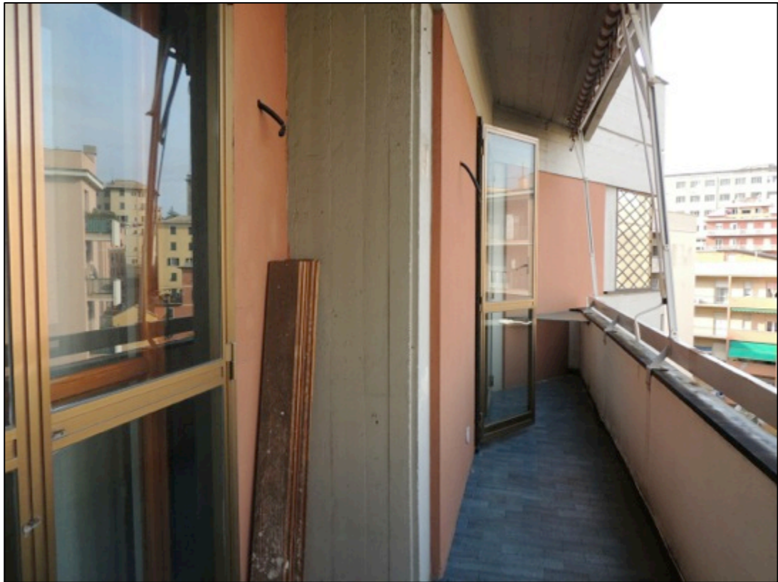
Foto 11 – terrazzo verso sud est
