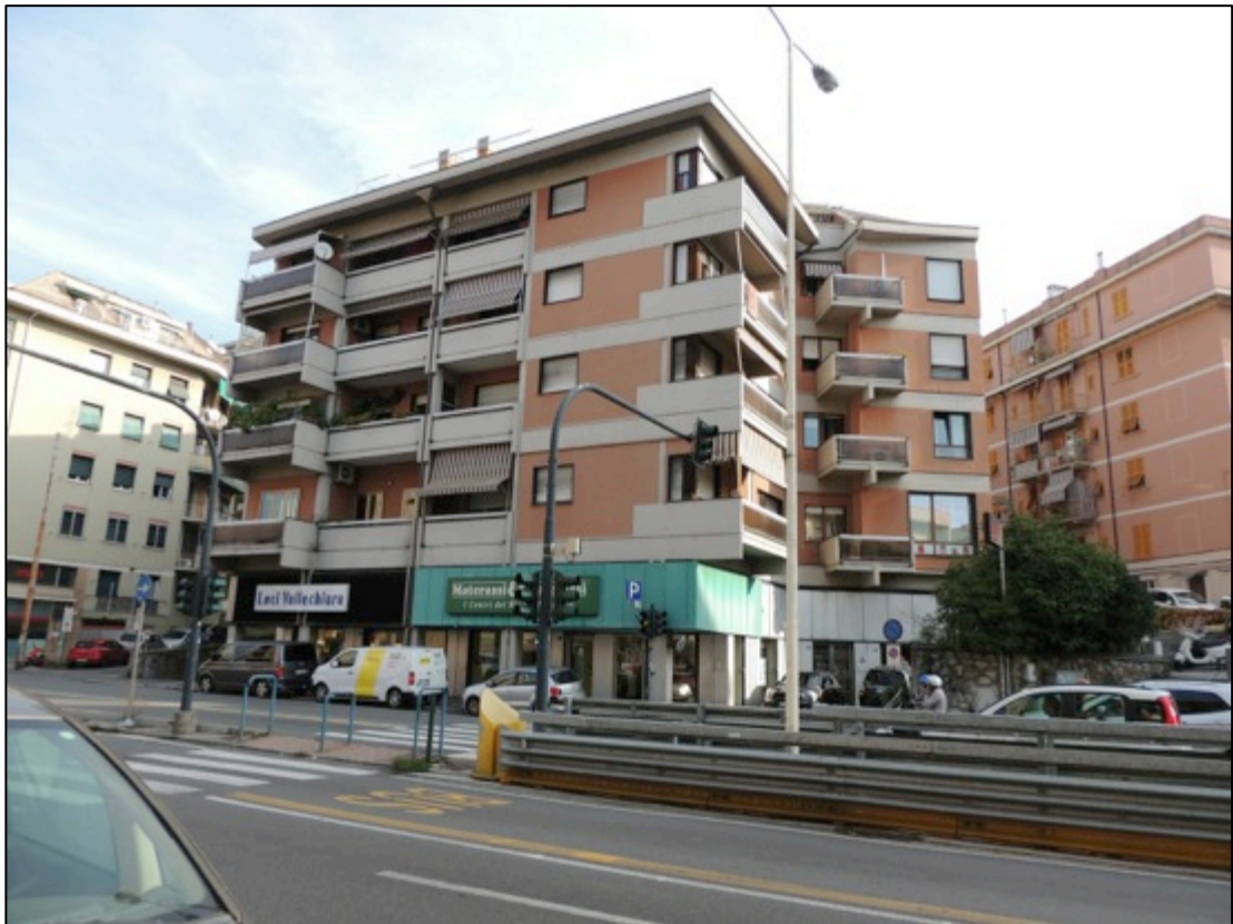
Foto 1 – il fabbricato di passo Vezzelli 4 visto da Corso Europa
