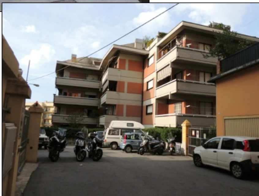
Foto 4 – il condominio visto da passo Vezzelli a nord (da via Borgoratti)
