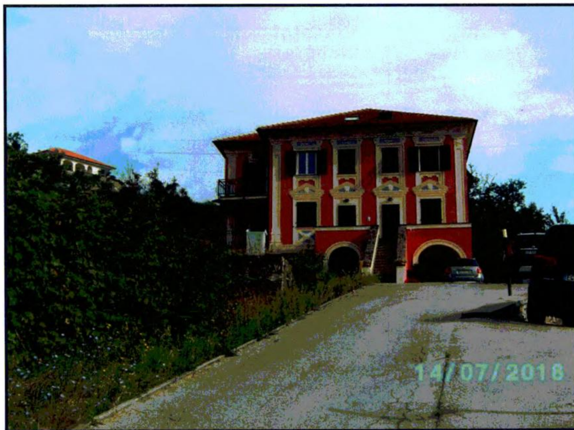
FOTO N. 4 - FACCIATA PRINCIPALE ACCESSO AL CIVICO
