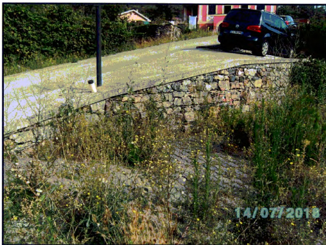
FOTO N. 49 - AREA SCOPERTA SUB 7
