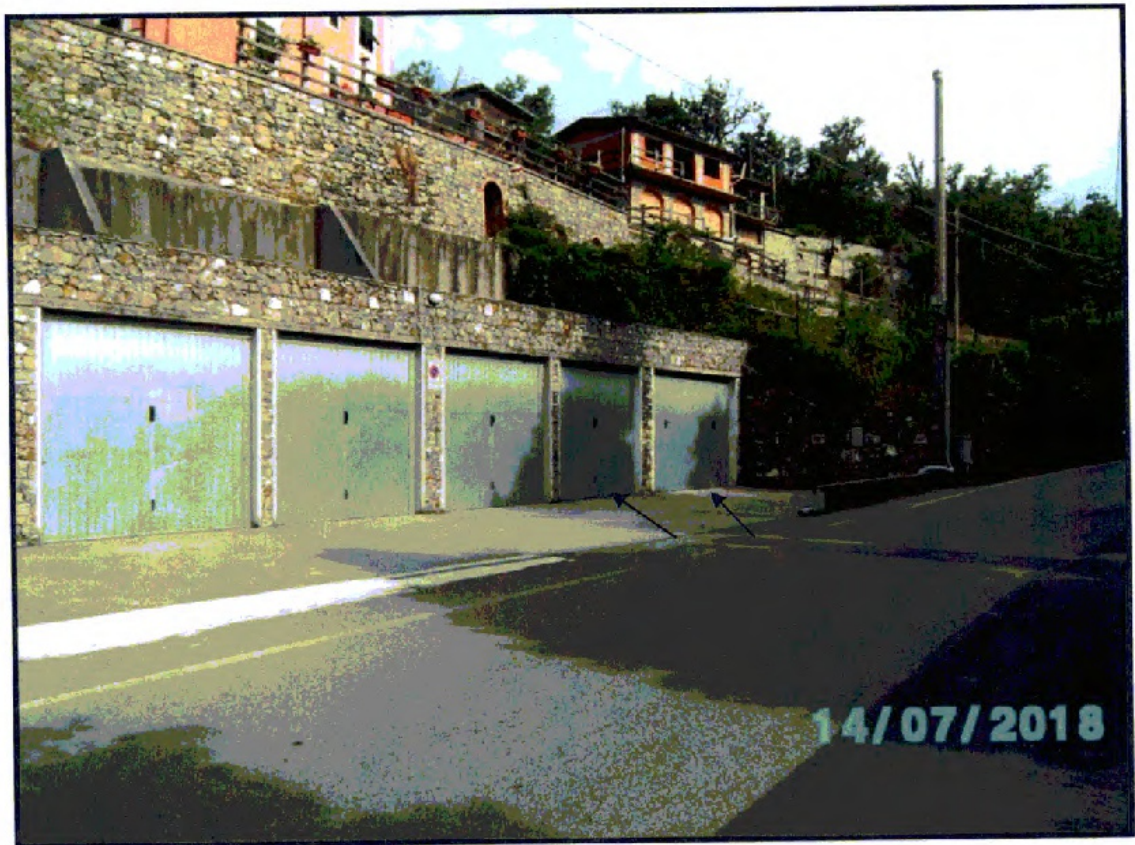
FOTO N. 37 - N. 2 BOX PERTINENZIALI
