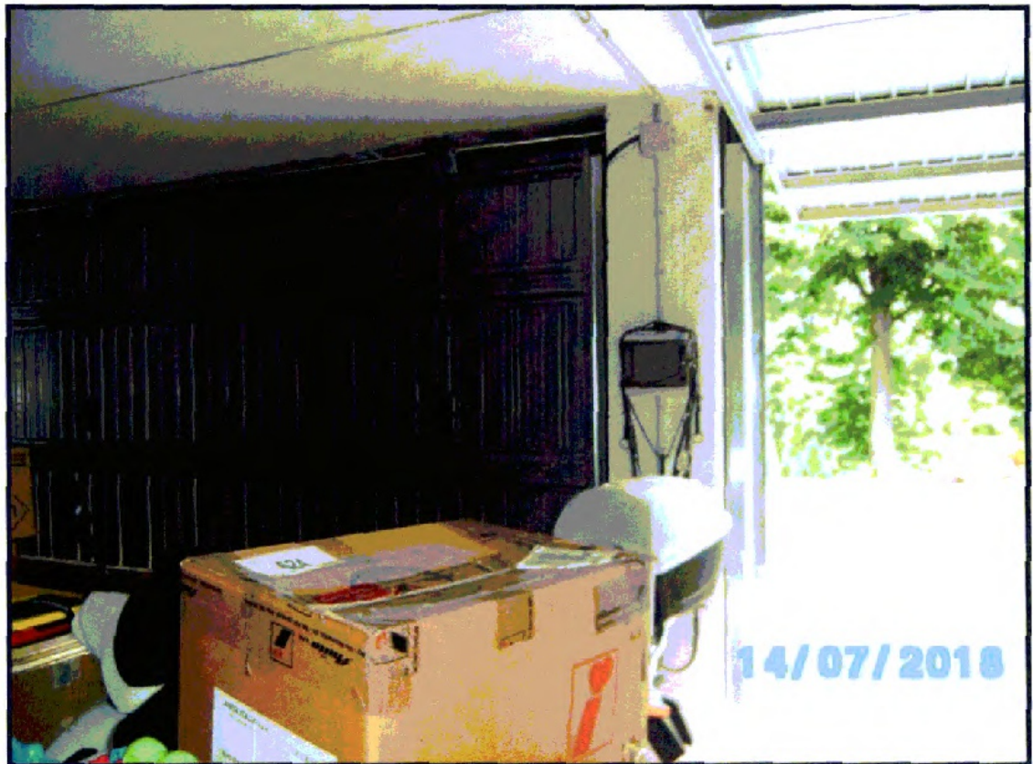
FOTO N. 43 - INTERNO BOX PERTINENZIALE SUB 2 e 3
