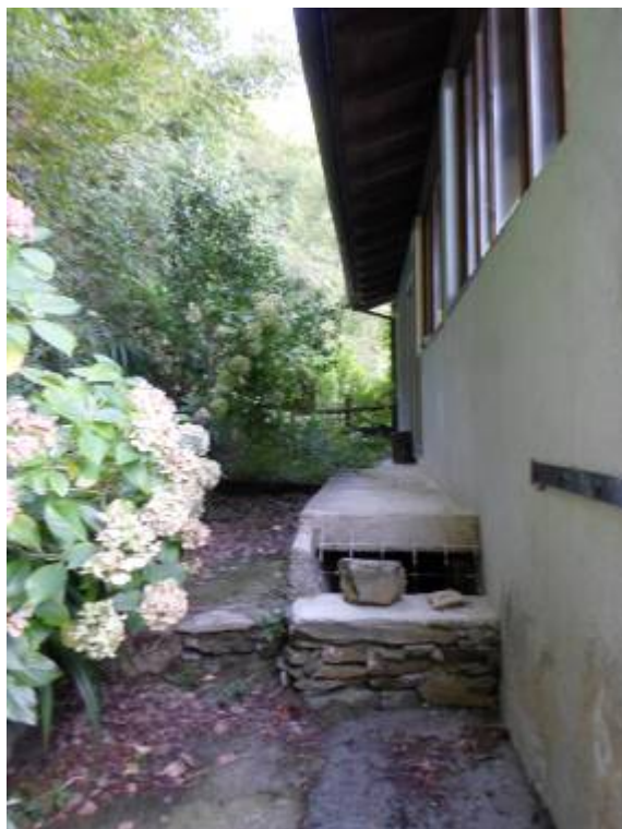
FOTO N. 5 Ripresa della facciata est del fabbricato.
