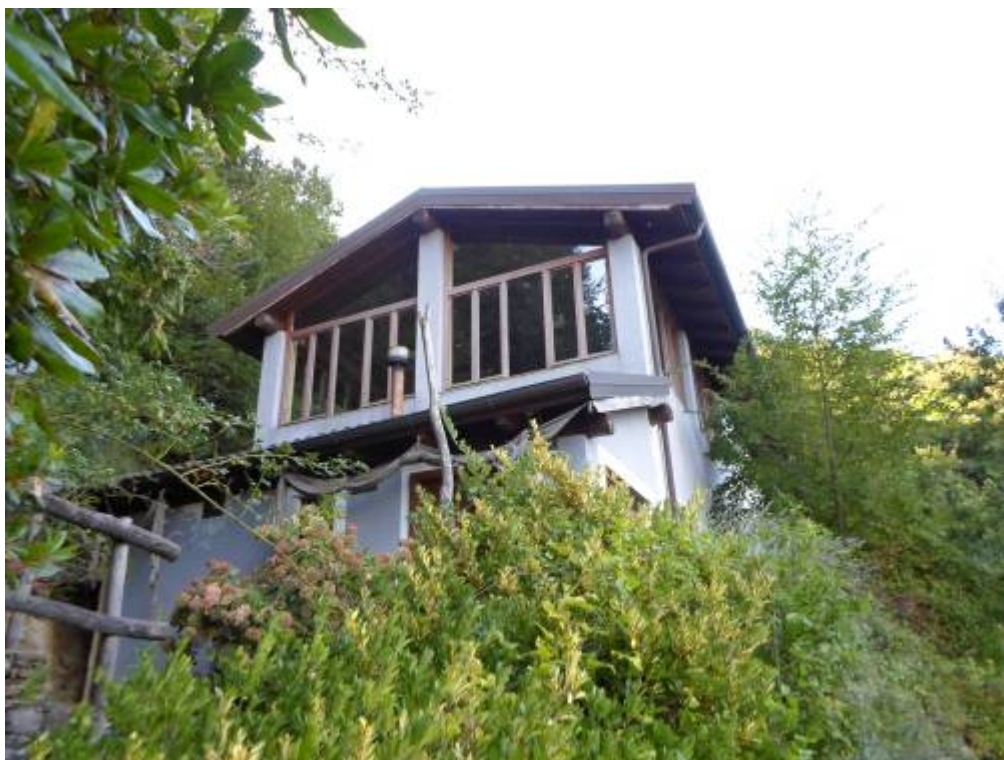
FOTO N. 3 Vista del prospetto nord del fabbricato.
