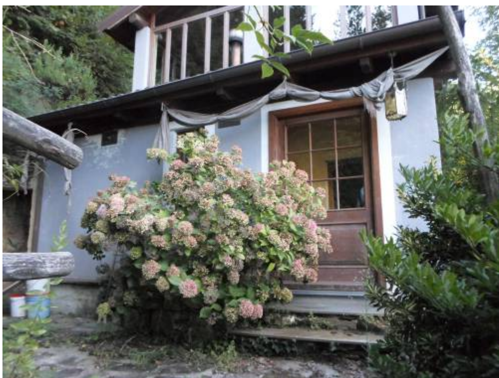
FOTO N. 4 Ulteriore ripresa del prospetto nord del fabbricato.
