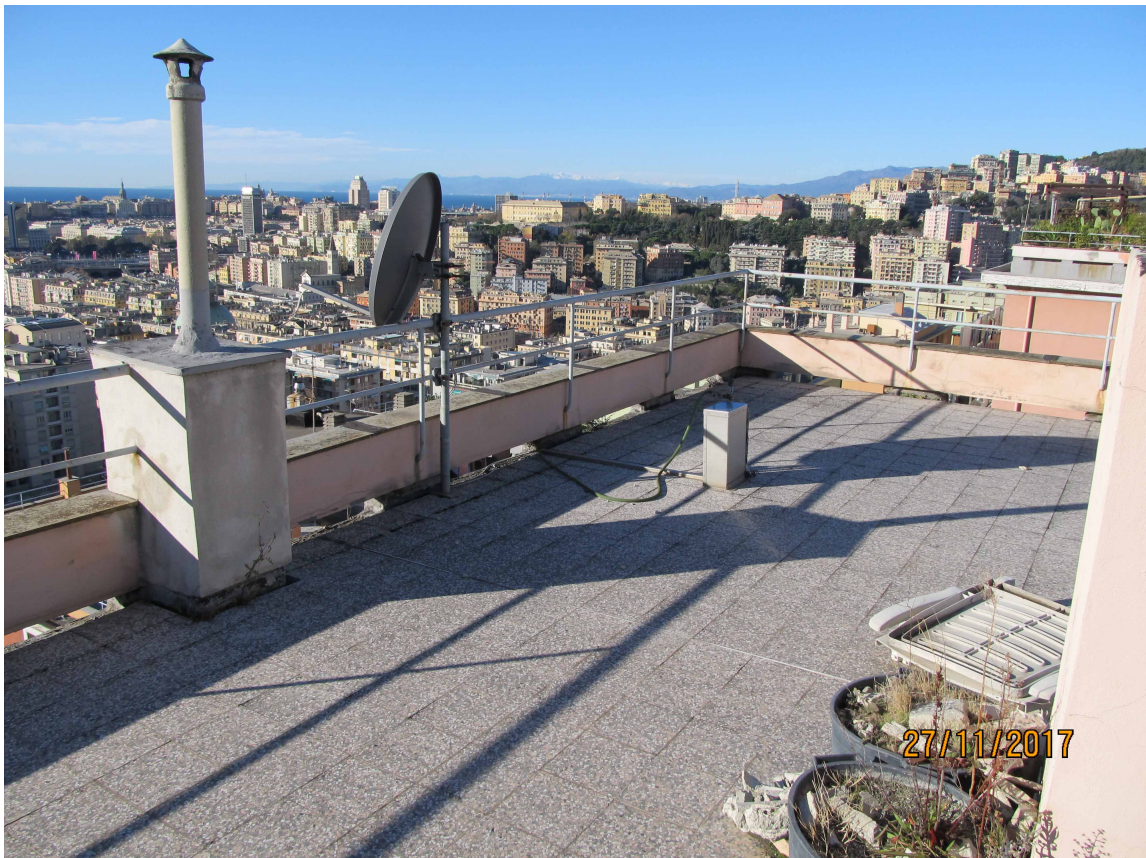
Fot. 15– terrazzo di copertura
