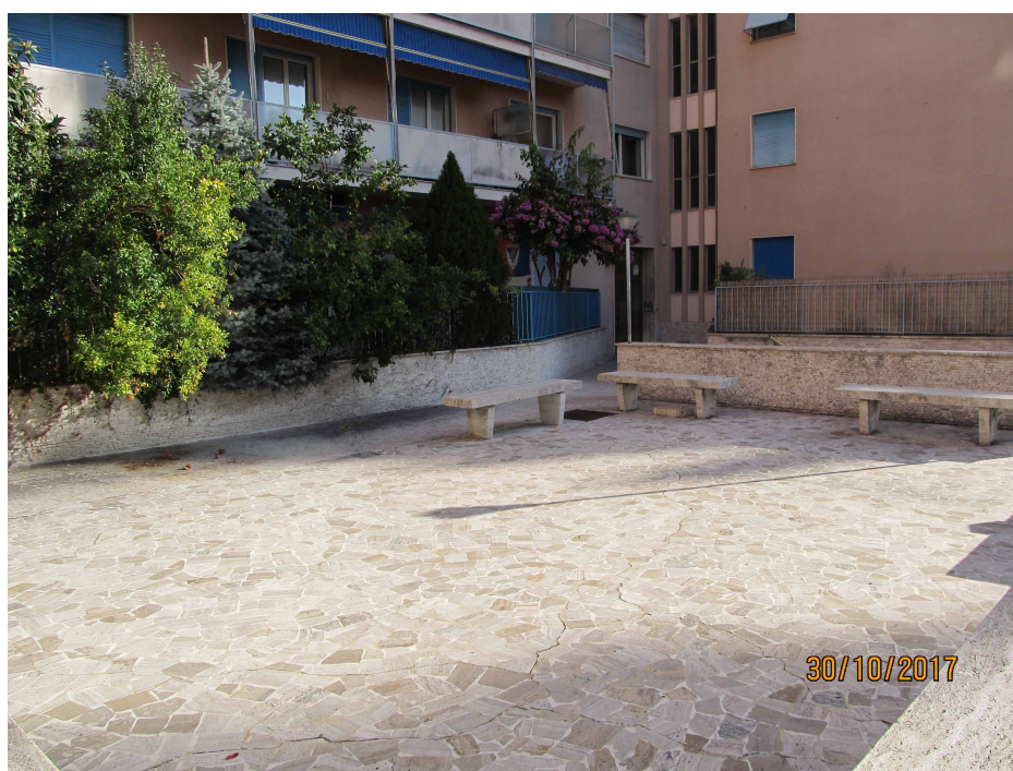
Fot. 9 – terrazzo condominiale
