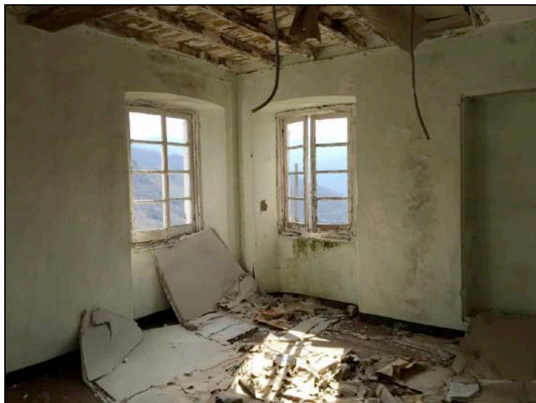
-Vani ubicati al primo piano-
