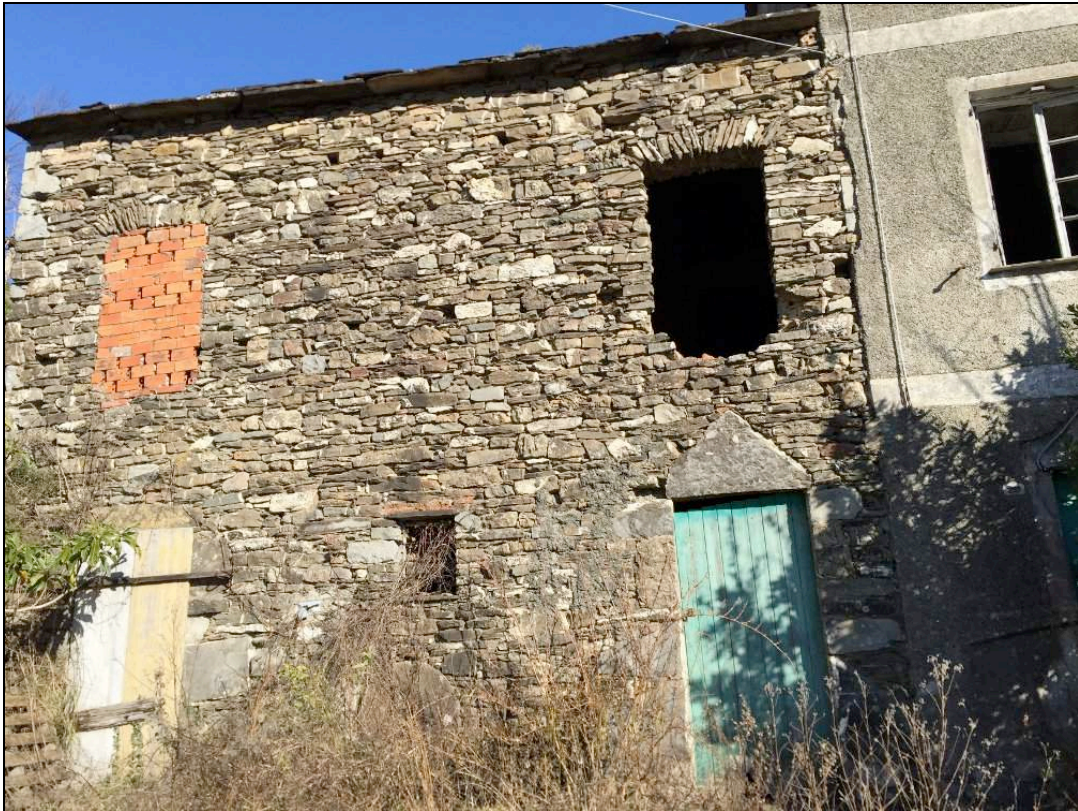
-Veduta generale fronte principale (lato ingresso)-
