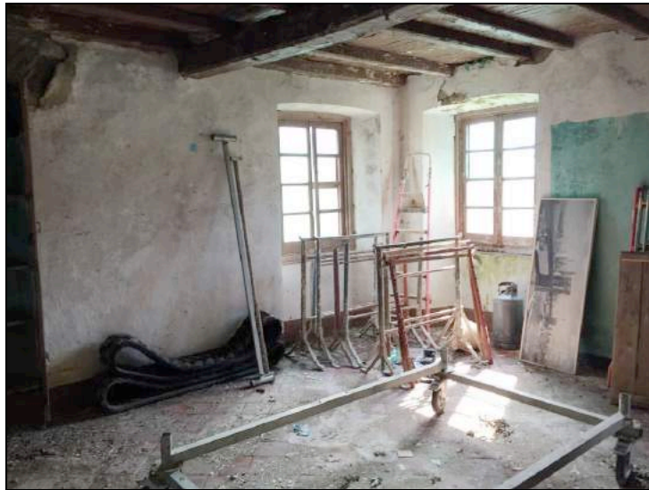
-Vani ubicati al piano terra-
