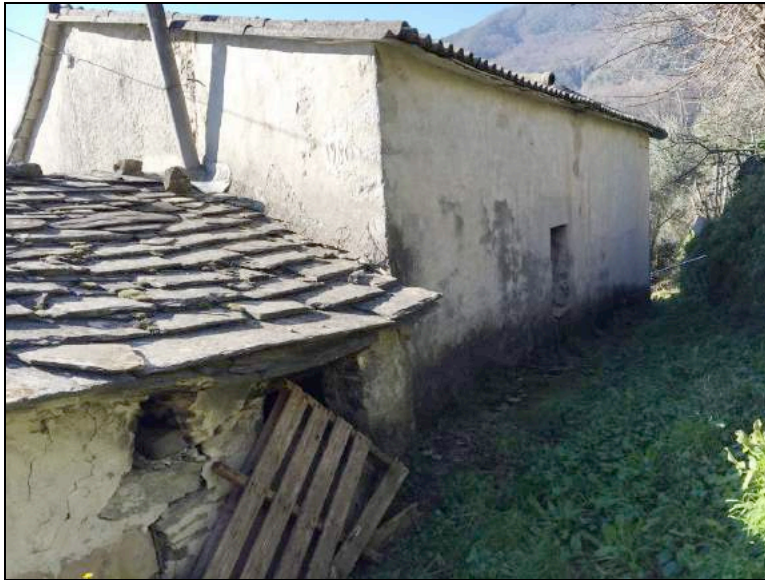
-Veduta generale immobile (prospetto a monte)-
