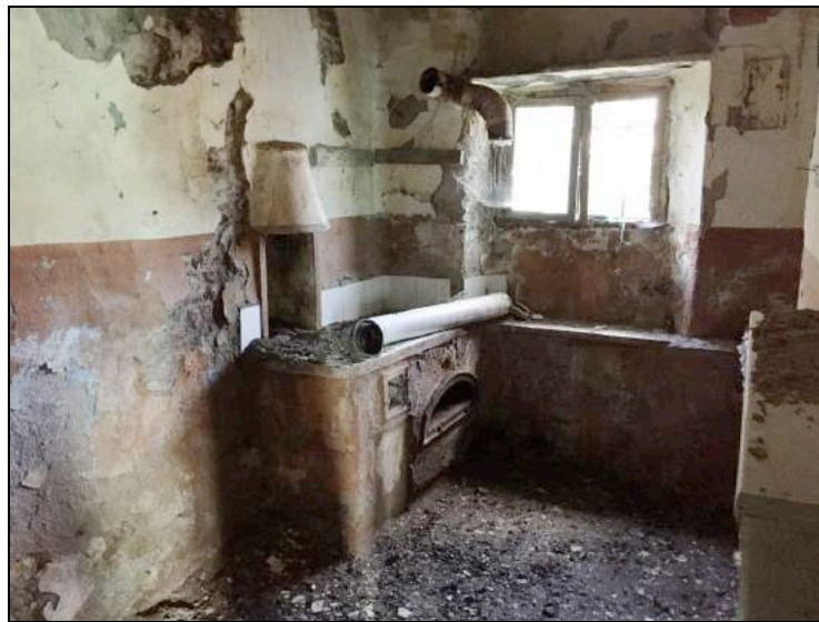
-Vani ubicati al piano terra-
