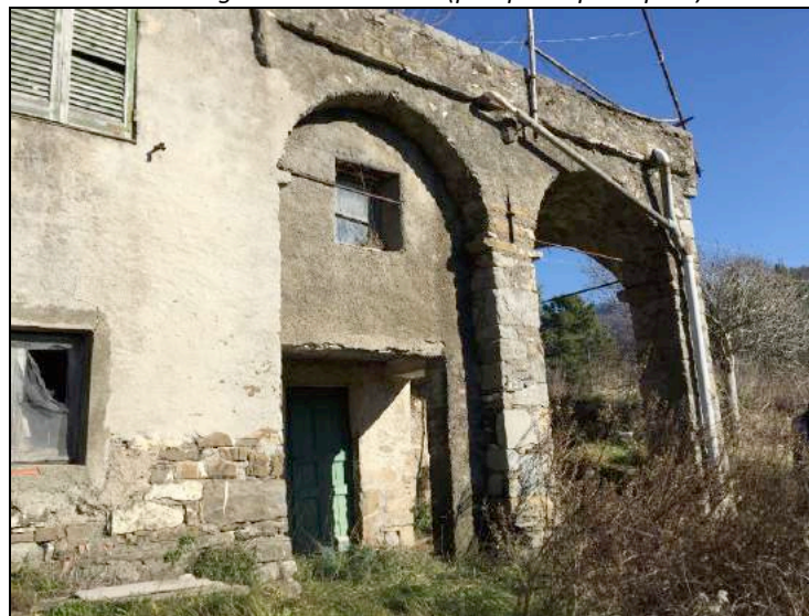
-Veduta generale immobile (prospetto principale)-
