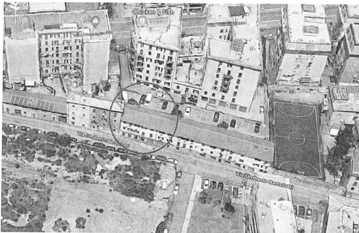
FIGURA 2 - VISTA AEREA FABBRICATO PIÙ AMPIO (PROSPETTO OVEST)
