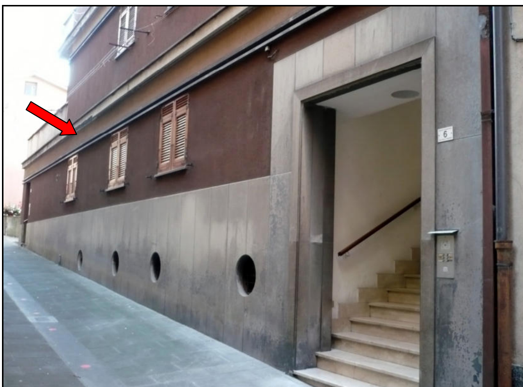
Foto n. 2 - Portone del condominio di via Carlo Marrè 6 e individuazione delle finestre dell'appartamento affacciati sulla via.
