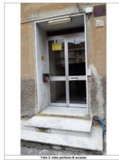
Foto 2: vista portone di accesso
