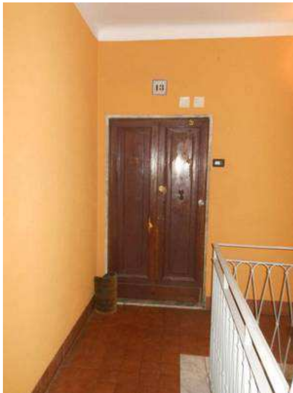
FOTO N° 04 – Porta caposcala vista da vano scale condominiale
