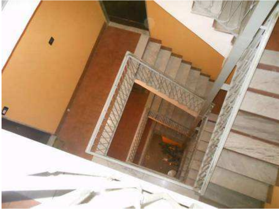
FOTO N° 03 – Vano scale condominiale visto da alto
