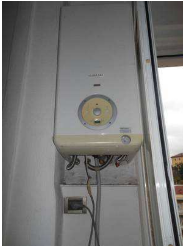
FOTO N° 12 – Impianto caldaia dismesso
