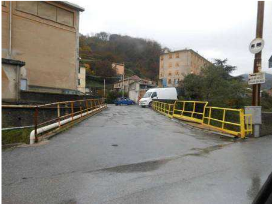
FOTO N° 07 – Accesso carrabile al Condominio da Via Trasta
