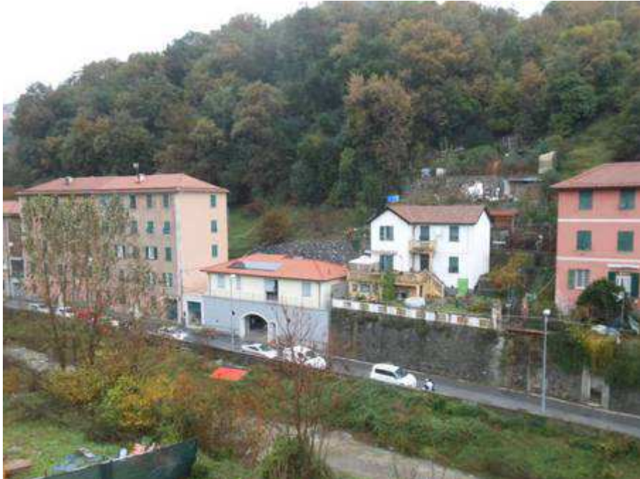
FOTO N° 10 – Vista da finestra cucina
