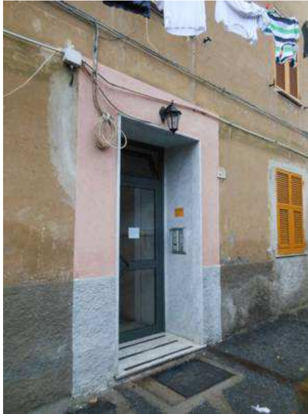
FOTO N° 01 – Lato Portone di ingresso condominiale
