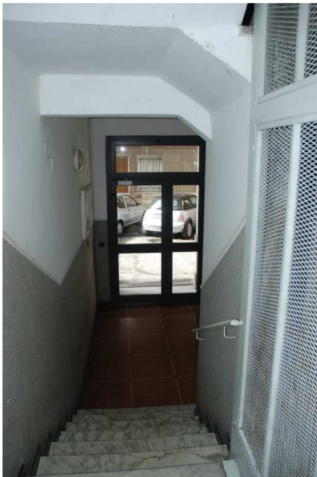
Foto n. 7- Atrio e vano scala
