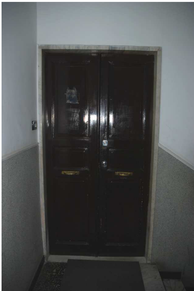
Foto n.10- Porta accesso interno n. 5
