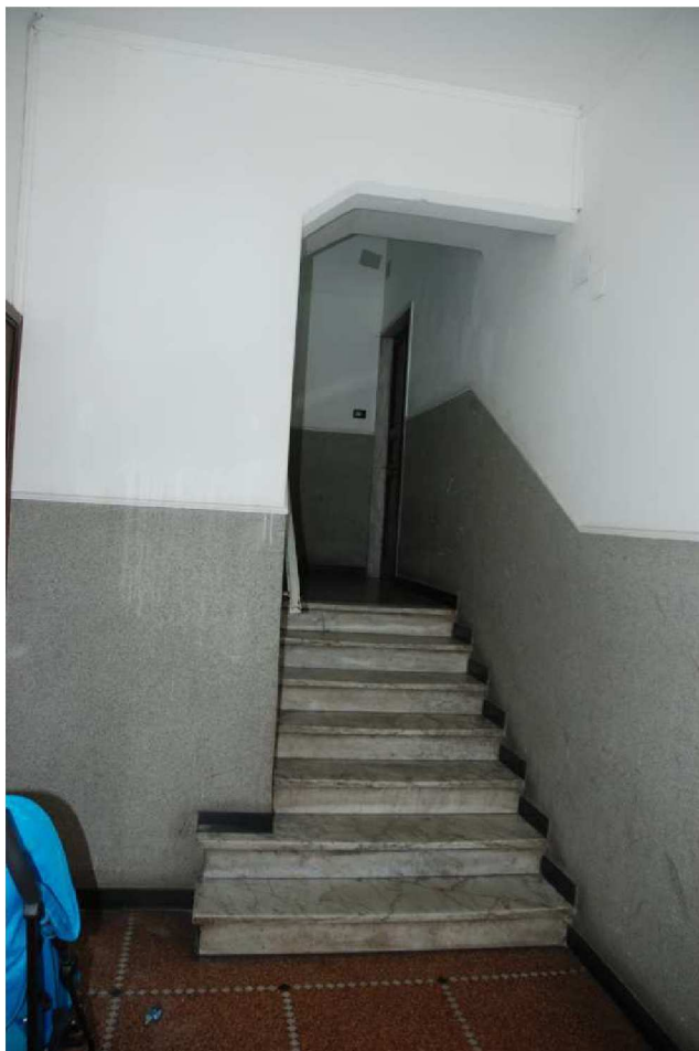
Foto n. 8- Atrio e vano scala
