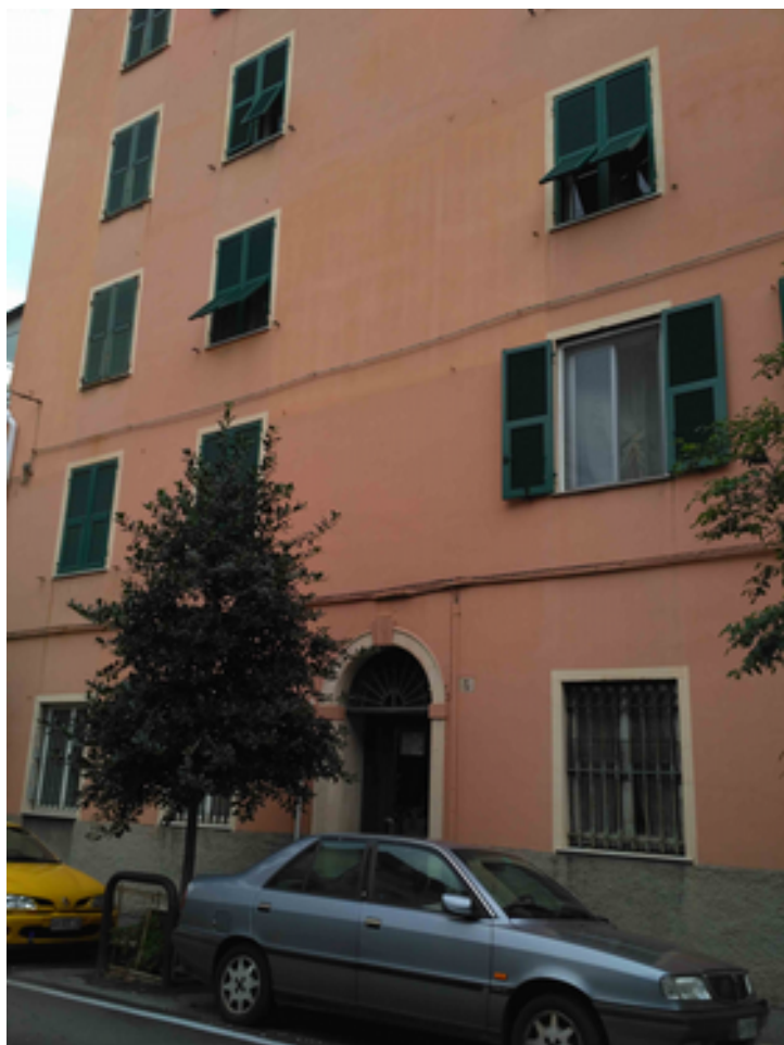
Vista esterna ingresso condominio civ. 3
