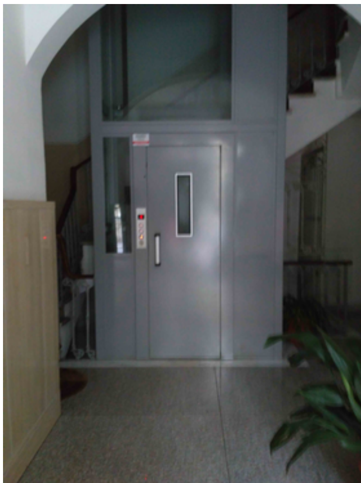
Vista androne condominiale con ingresso ascensore
