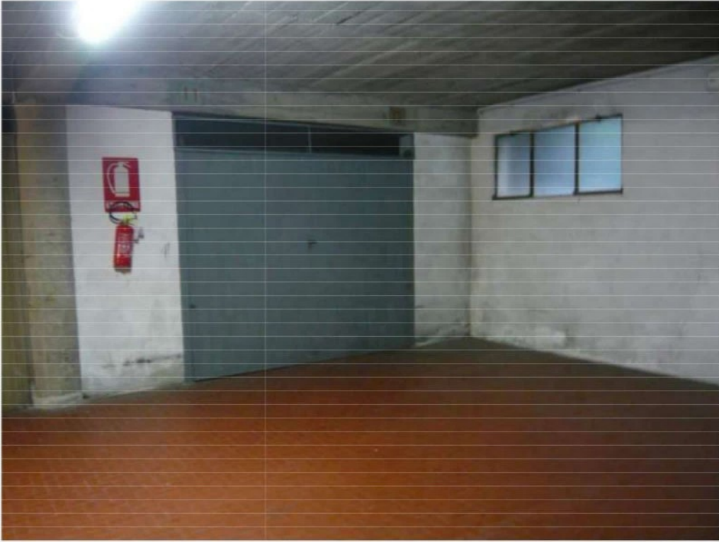
corsia di manovra box n.11-12
