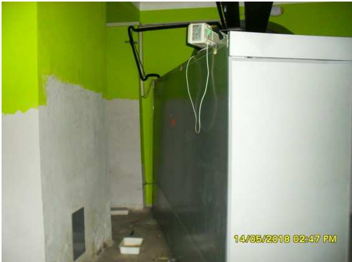
Foto 20: Stato delle pareti
