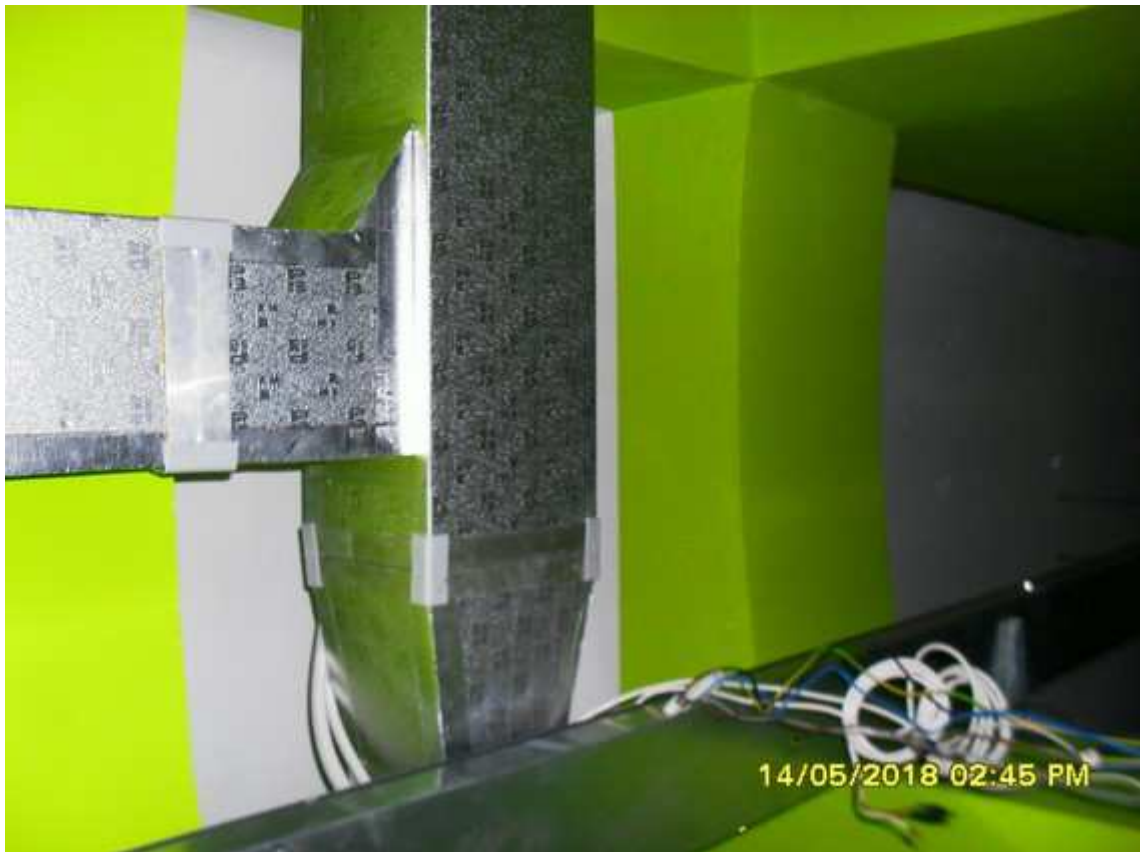
Foto 12: Impianti a soffitto
