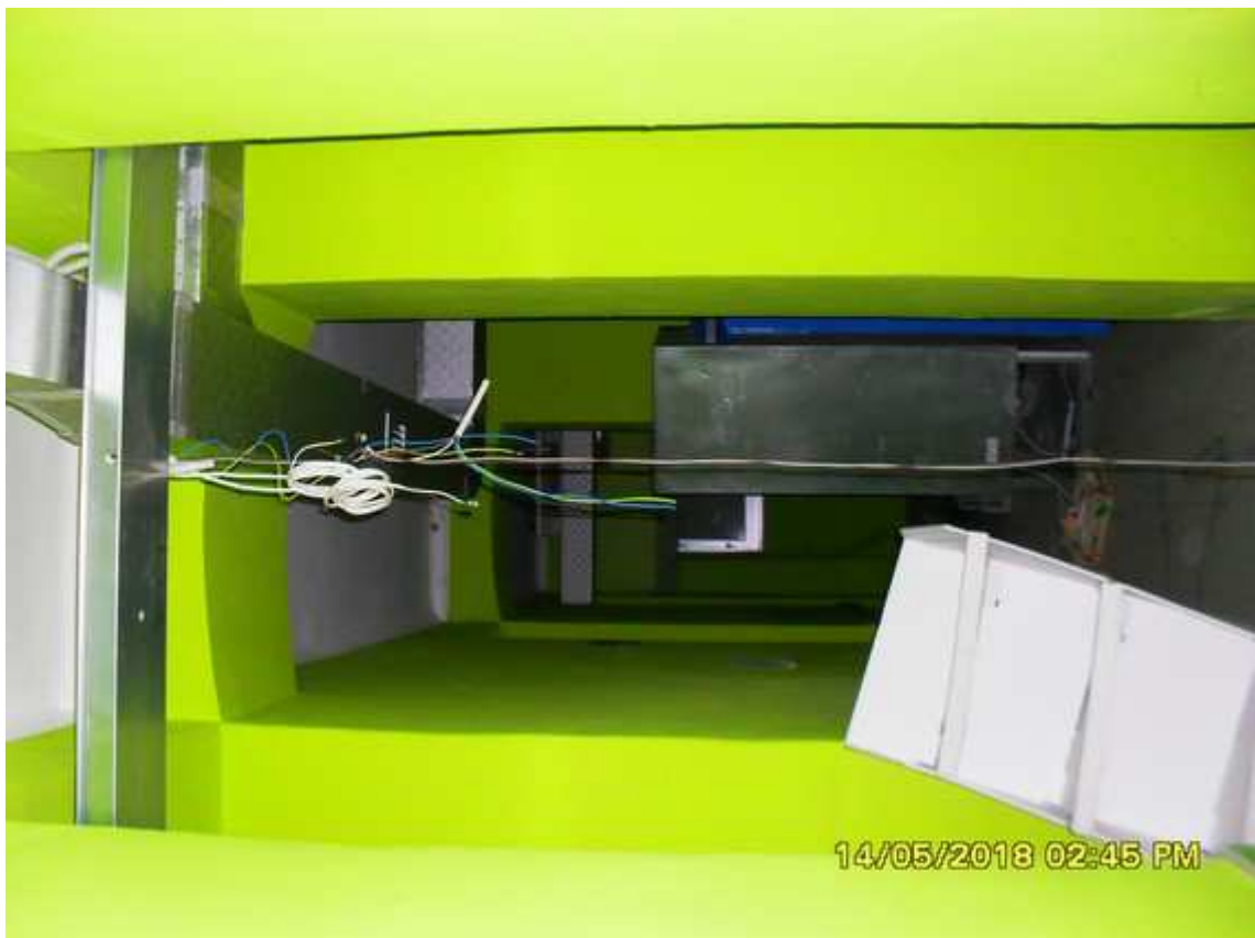
Foto 14: Corridoio interno ed impianti
