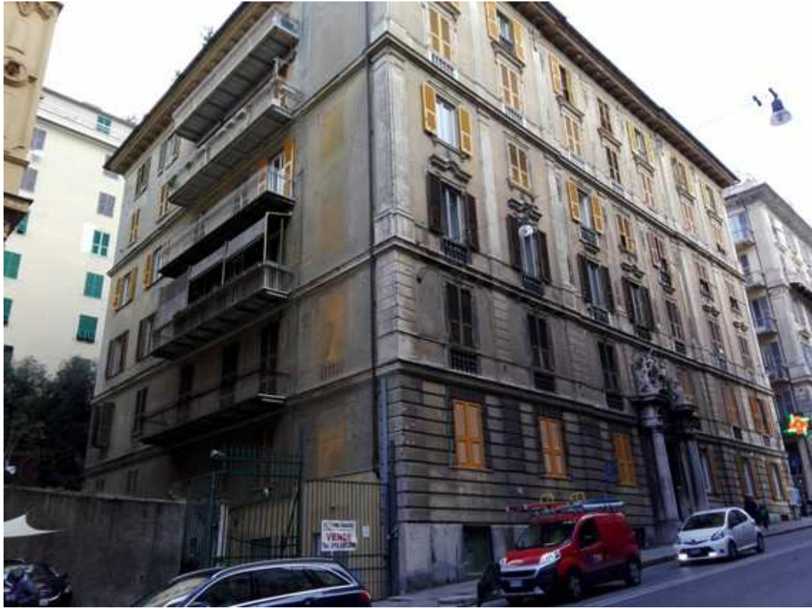
Foto 3: Prospetto sud-ovest e sud-est dell'edificio
