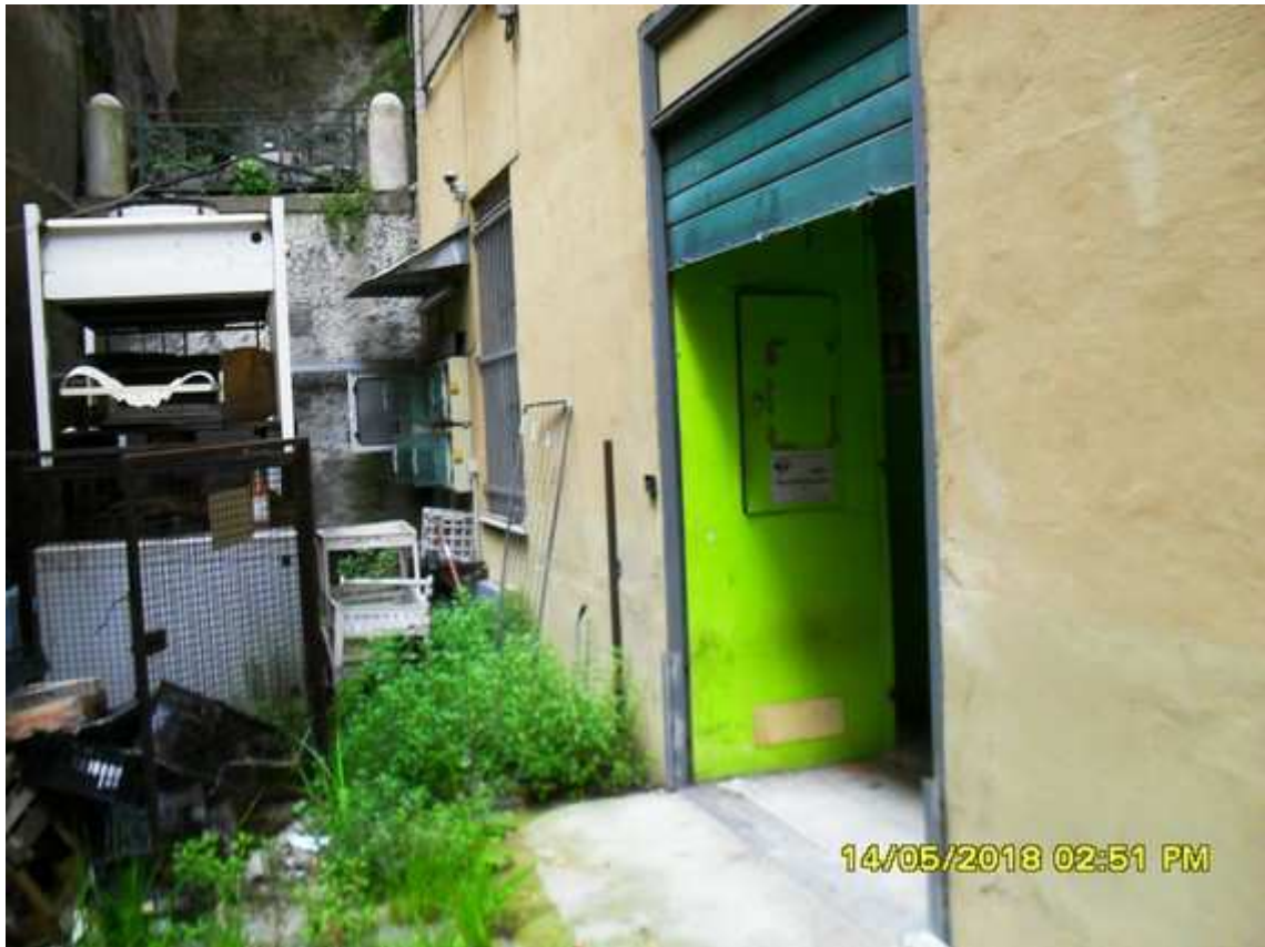
Foto 25: Ingresso del locale
