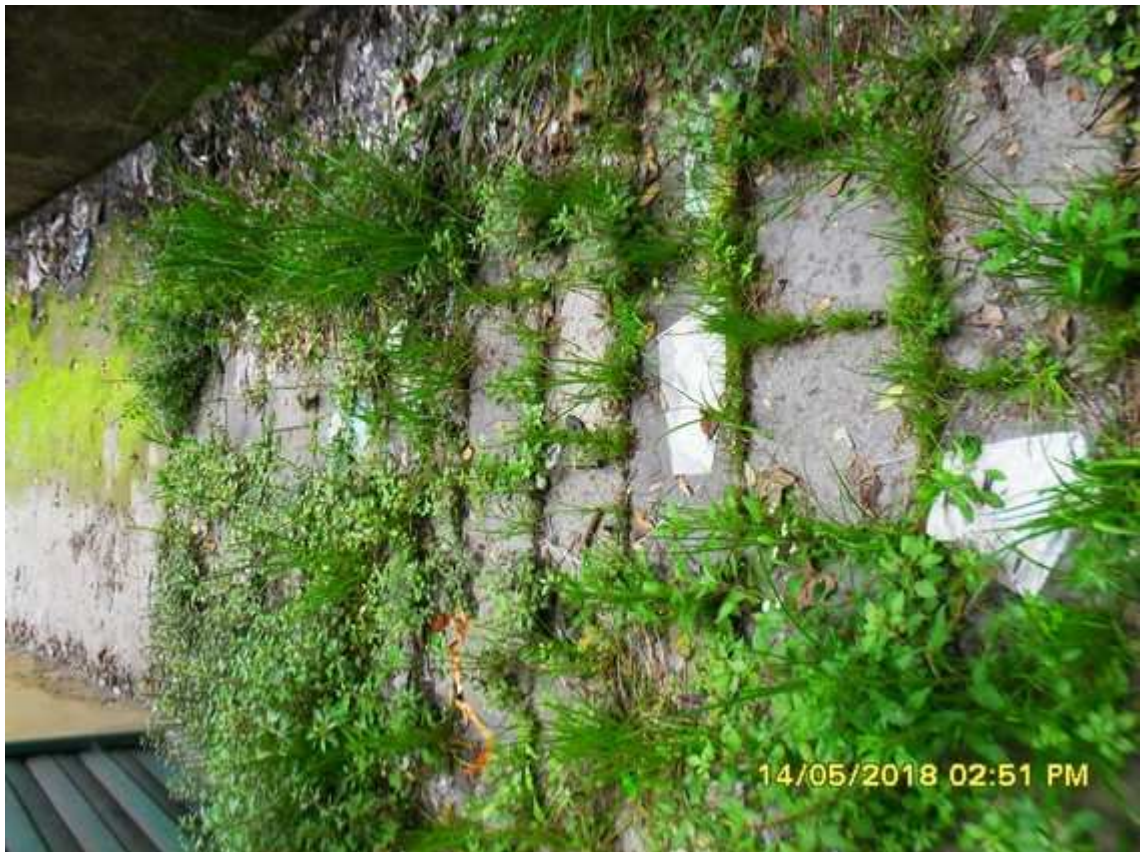
Foto 24: Stato della pavimentazione della corte esterna
