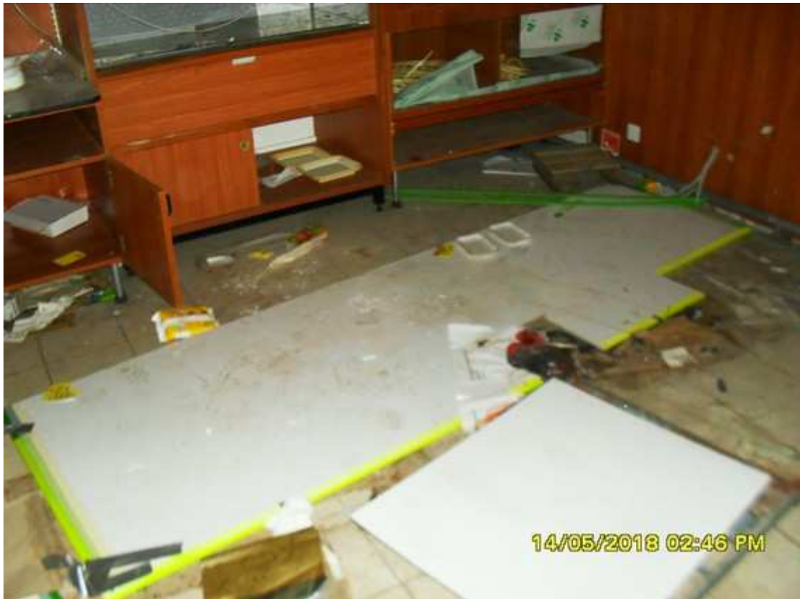
Foto 17: Materiali lasciati durante la ristrutturazione
