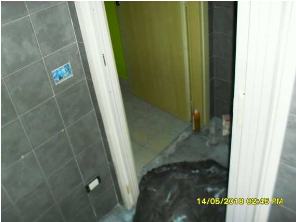
Foto 9: Servizio igienico ed antibagno
