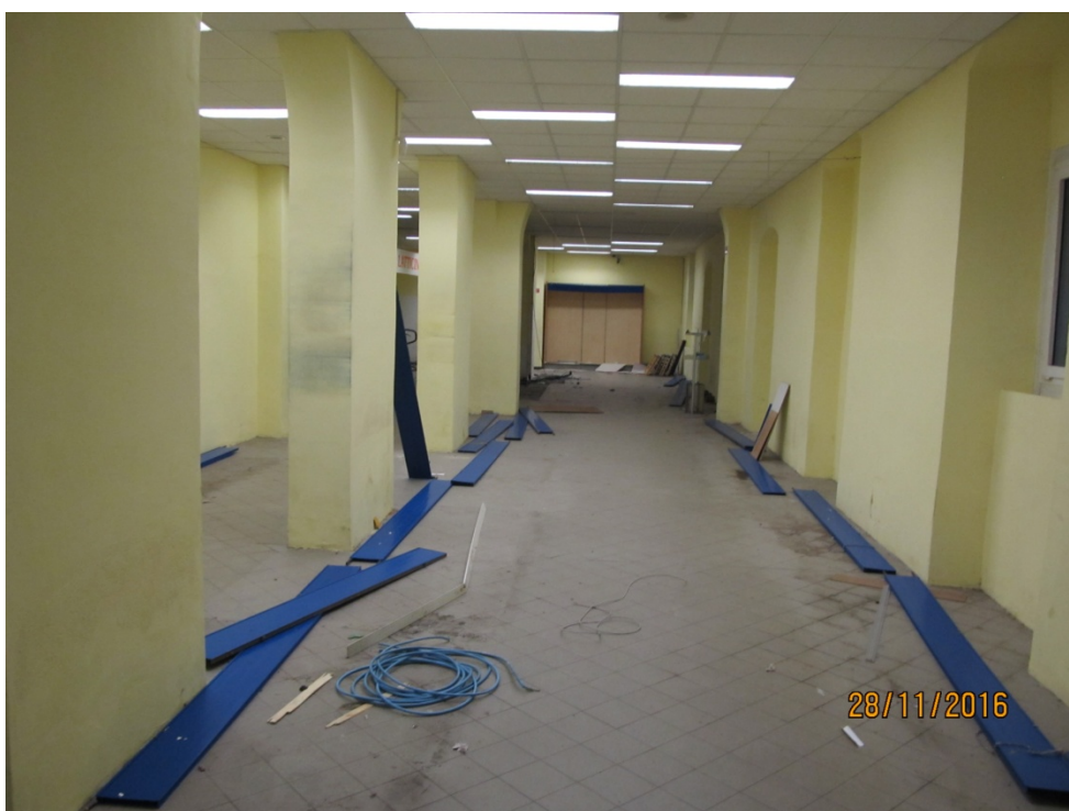
Fot. 2 - interno del magazzino
