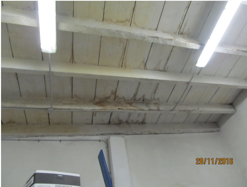
Fot. 5 - tracce di infiltrazioni a soffitto
