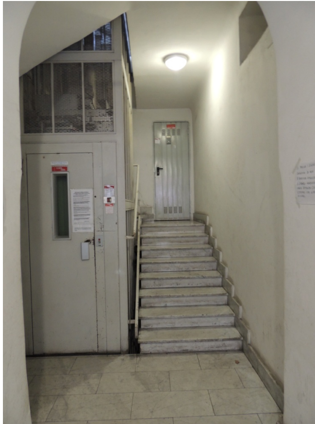
Foto n 3 Rampa di scale poste all'ingresso del caseggiato con vano ascensore.
