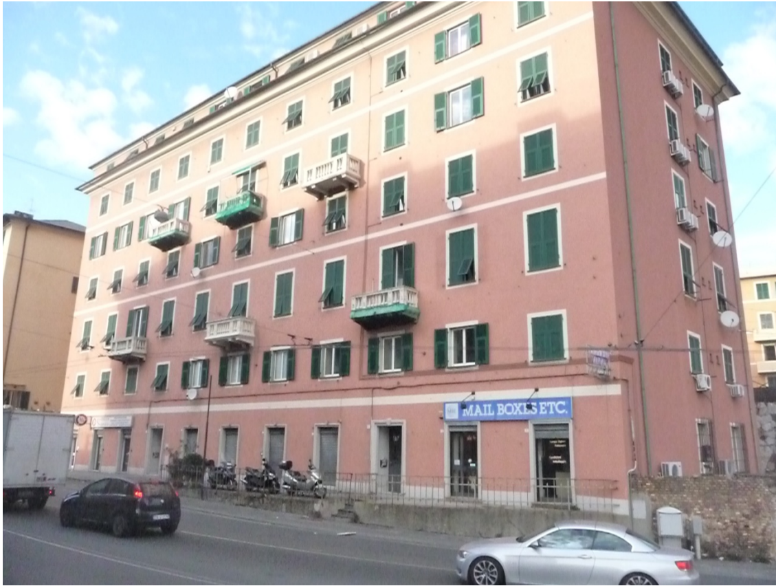
Foto n 1 Edificio sito in Piazza Nicolo' Barabino n civ.1 e 3 Genova
