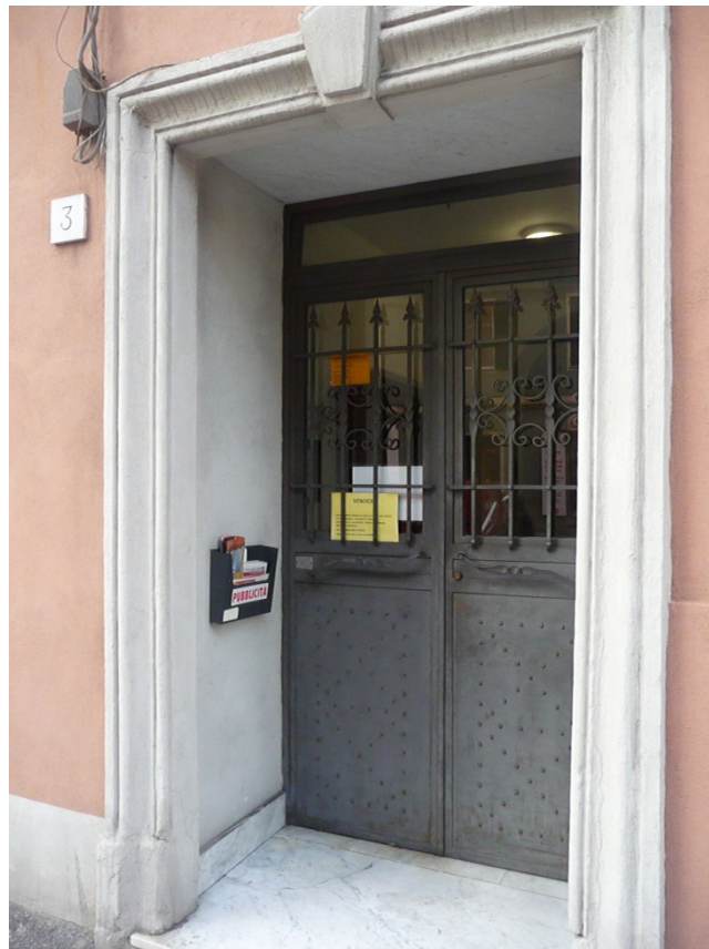
Foto n 2 Portone di ingresso in ferro e vetro del caseggiato n.3
