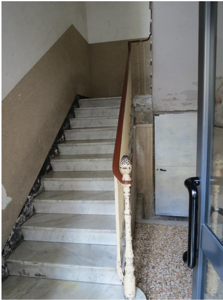
FOTO n. 7 : il corpo scala condominiale
