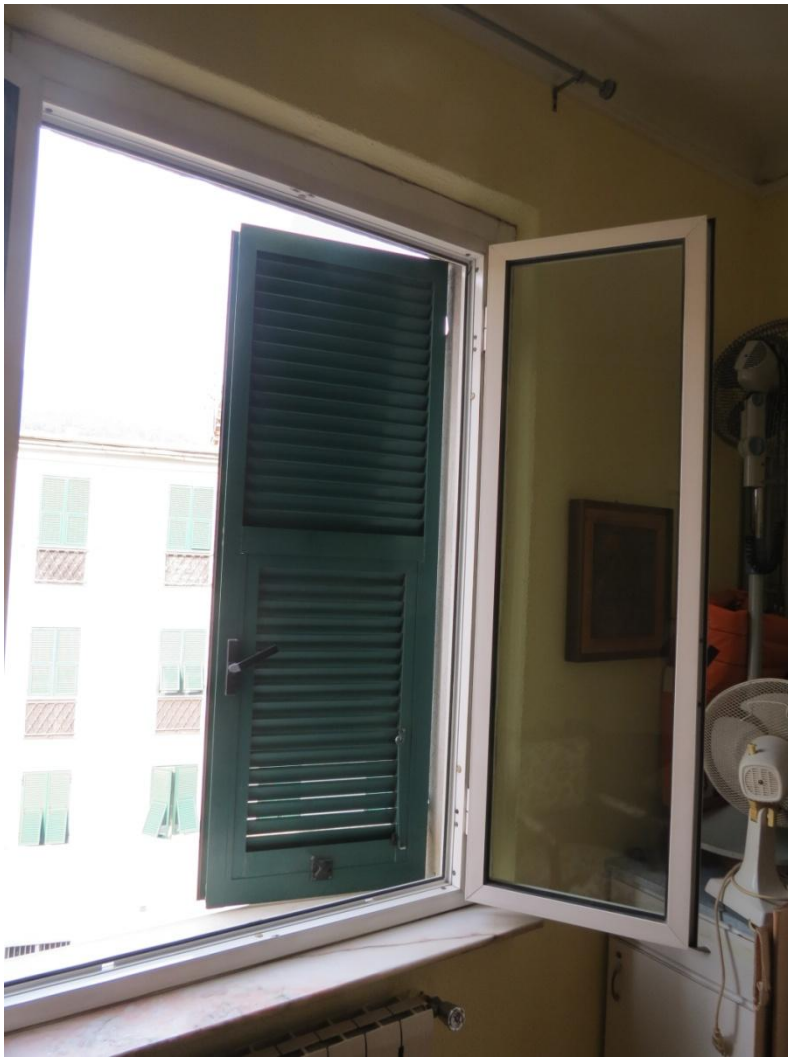
FOTO n. 23 : particolare di un serramento
