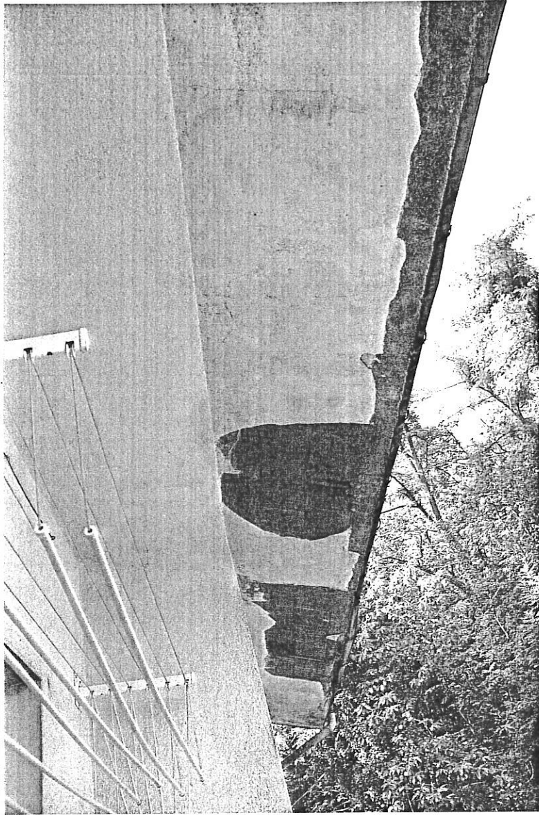
Foto n.32– Particolare copertura ripresa dal poggiolo camera 3
