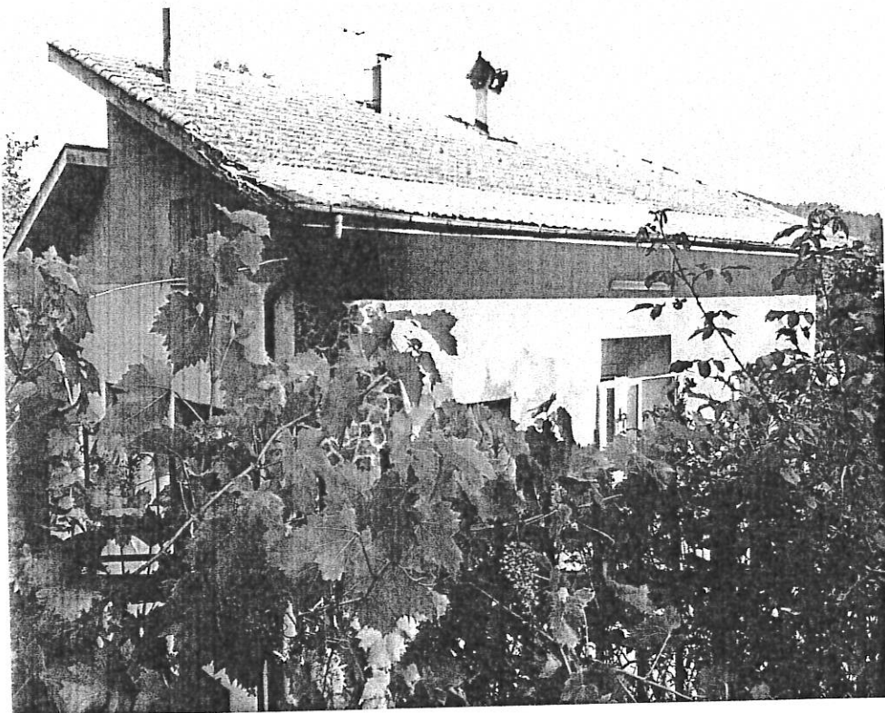
Foto n. 6 – Facciata est edificio. Visibili le condizioni della copertura .
