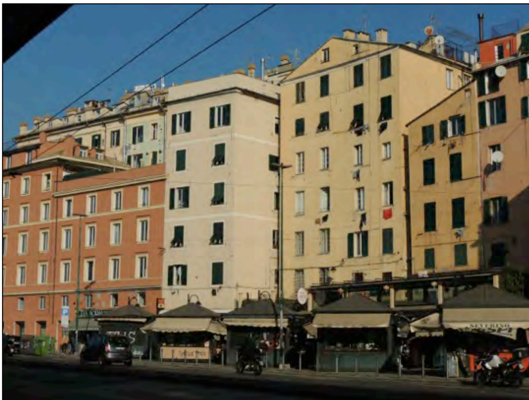
Foto 3 – il fabbricato di via di Pré 58 ripreso da via Gramsci, inserito nel contesto edificato, alle spalle del mercatino stanziale.
