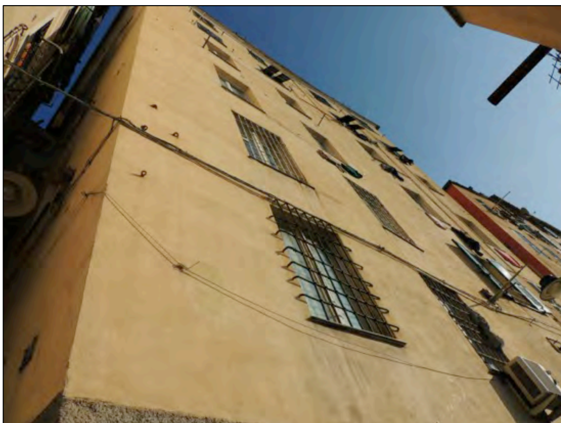
Foto 2 - il fabbricato di via d Pré 58 ripreso dall'angolo su piazzetta dello scalo
